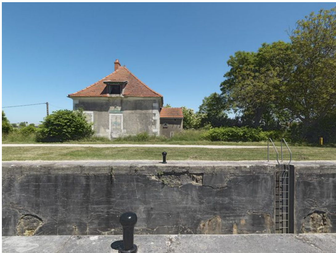
Maison éclusière vue de face : les ouvertures sont aujourd'hui murées.
