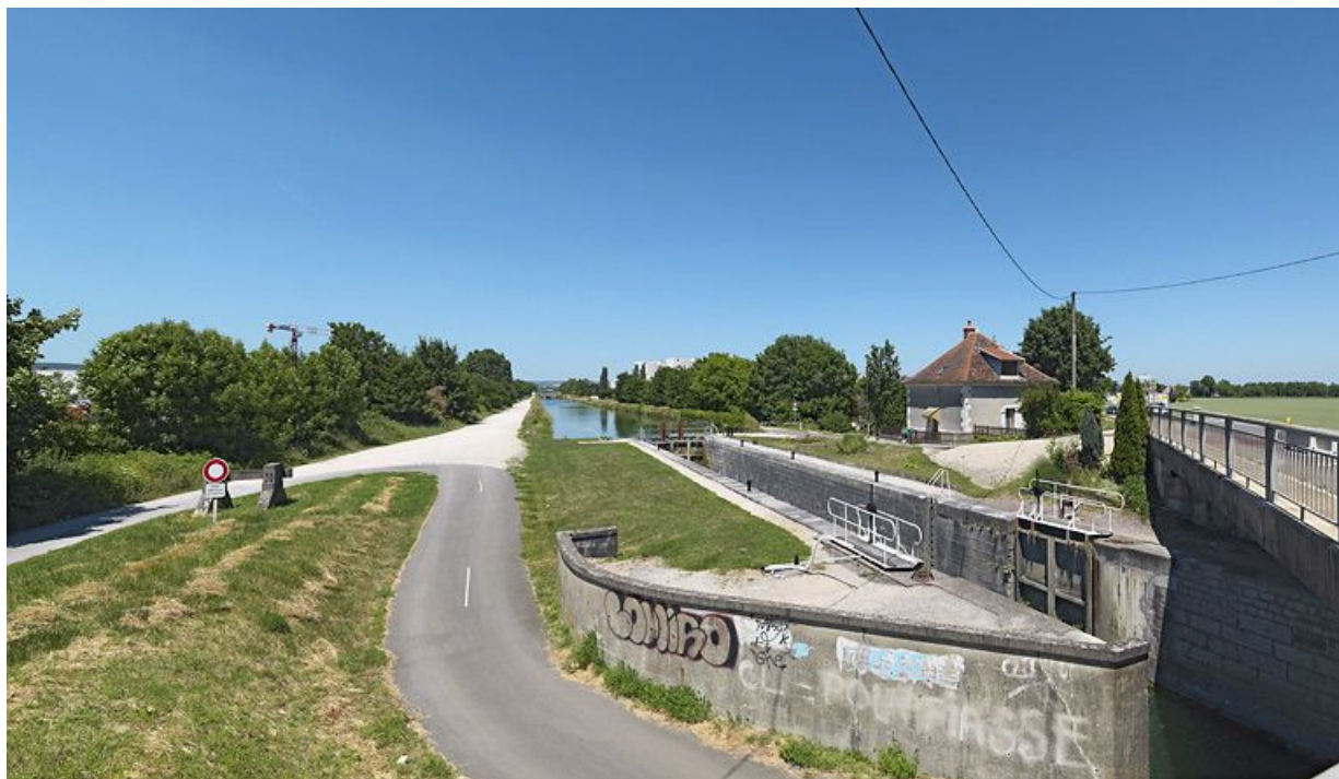
Site vu d'aval. Le désaxement du pont sur écluse par rapport au sas est nettement visible.
