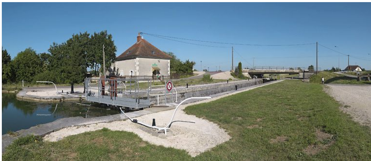
Site de l'écluse 59 du versant Saône, dite de Beauregard, à Longvic : vue d'amont.
