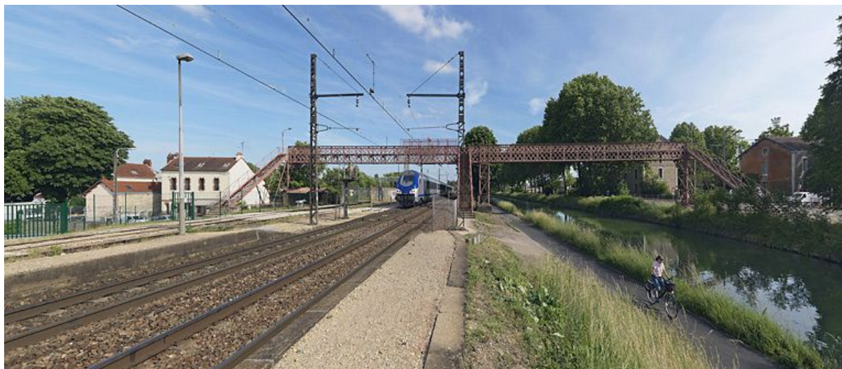
La passerelle, vue d'ensemble d'amont. Le site SNCF qu'elle dessert est à droite de l'image.
