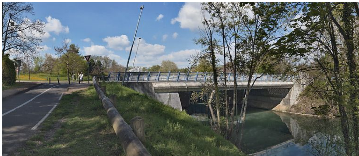
Pont moderne remplaçant le pont ancien sur l'écluse 54 S : vue d'aval. 21, Dijon, lieudit : Larrey
