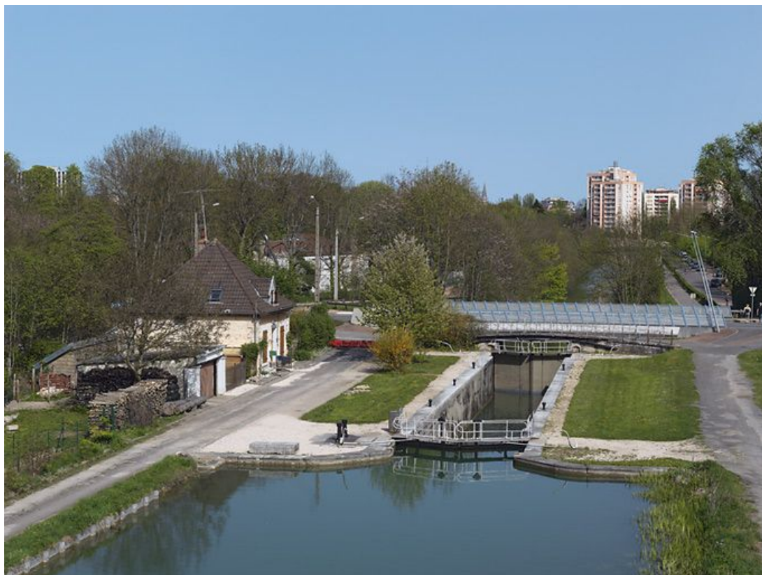
Le site d'écluse du d'amont avec en fond le pont ancien sur écluse (IA21003790) et le nouveau pont (IA21003791). 21, Dijon, lieudit : Larrey
