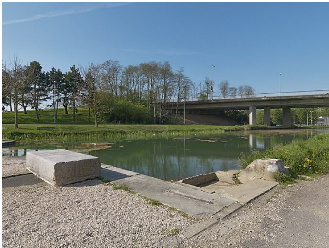
Tête amont de l'écluse, rive gauche : le lavoir domestique du site d'écluse. A l'arrière-plan, le pont isolé IA21003788. 21, Dijon, lieudit : Larrey
