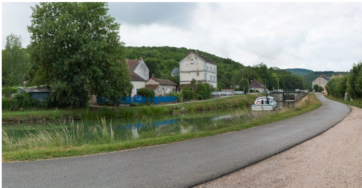
Vue de la maison de garde et de la maison de perception de Pont-de-Pany.
