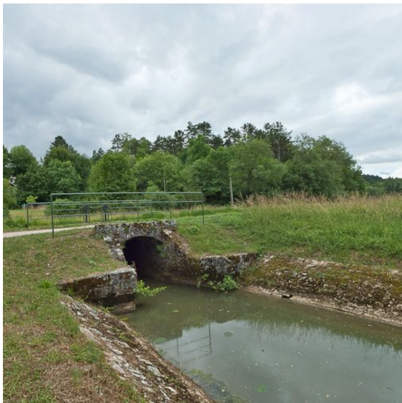
Vue de la prise d'eau et du petit pont en maçonnerie.
