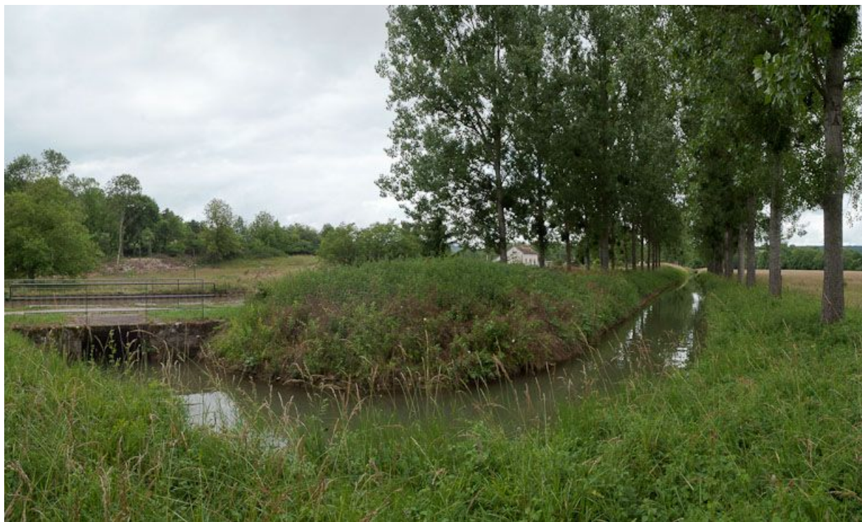
Vue de l'arrivée de la rigole d'alimentation dans le bief 38 du versant Saône.
