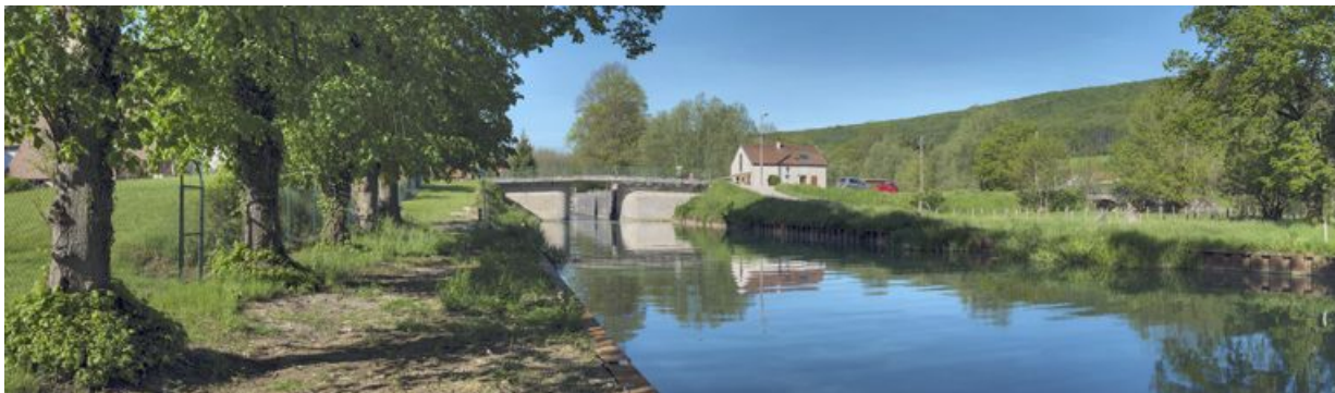
Pont sur écluse pris d'aval. A droite, le pont ancien sur l'Ouche.
