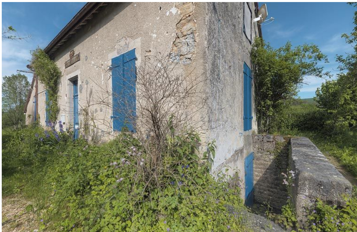
La descente de l'escalier de la cave de la maison éclusière.
