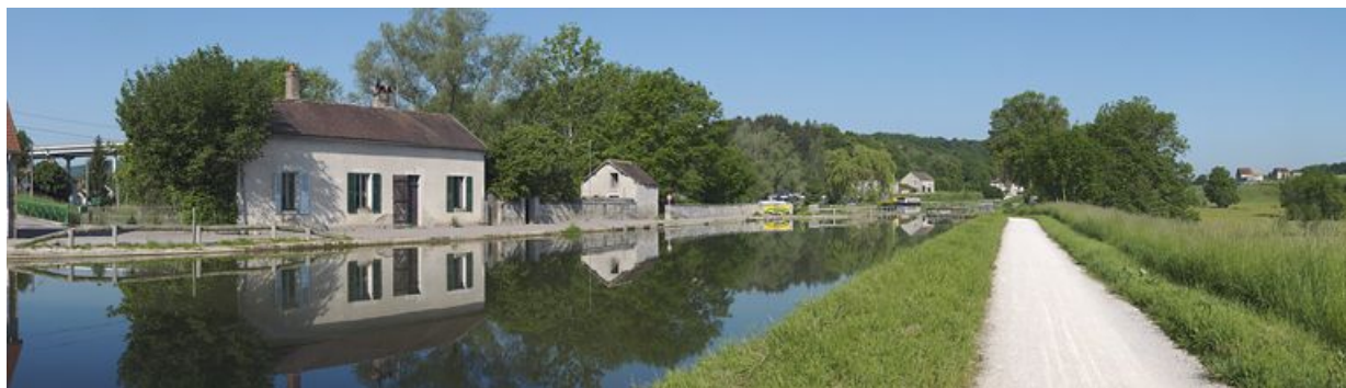
Panorama sur le site de Pont-d'Ouche : le viaduc autoroutier ; la maison du conducteur, le pont-canal.
