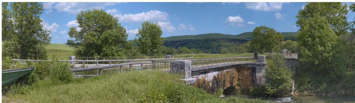
Le pont-canal vu d'amont. A droite : l'Ouche qui passe sous le pont-canal.
