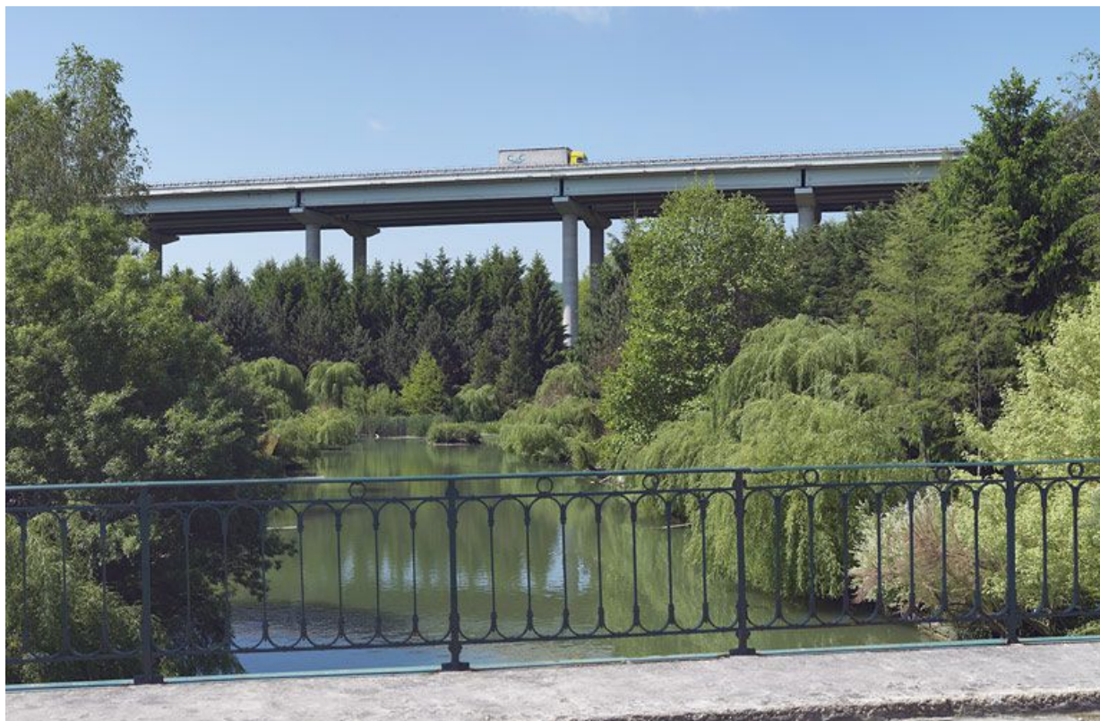
Le viaduc surplombant l'ancienne gare d'eau des houillères d'Épinac.
