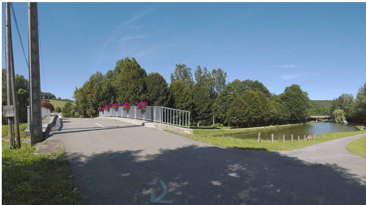
Le pont isolé de Crugey : le port de Crugey, le viaduc en arrière-plan.
