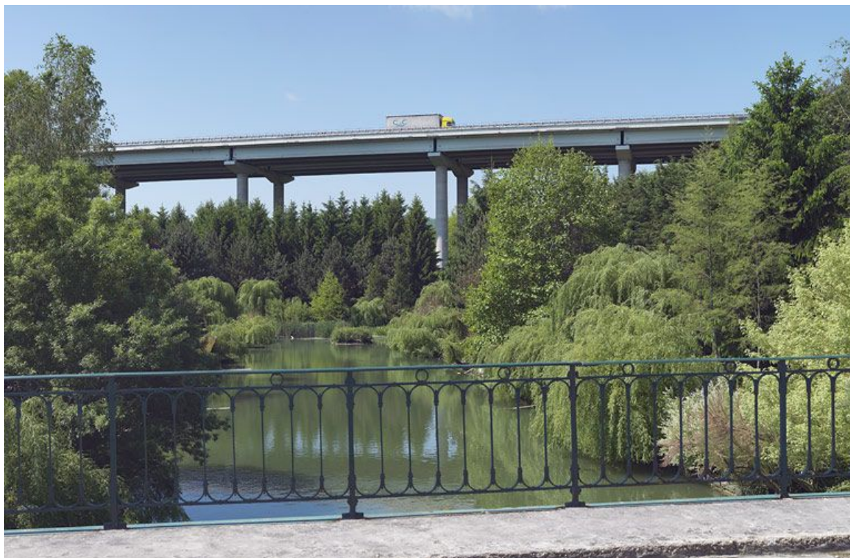
Le viaduc surplombant l'ancienne gare d'eau des houillères d'Epinac.
