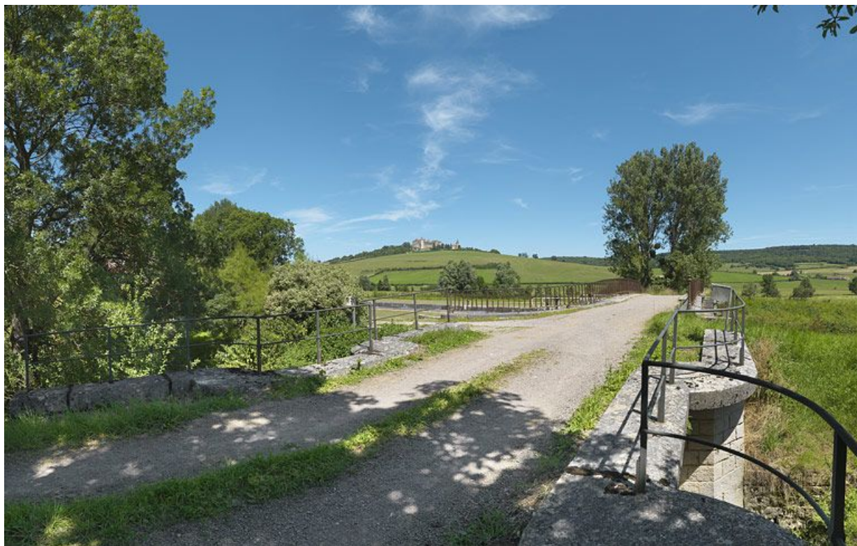
Pont sur la rigole du Tillot, dans la continuité du pont sur écluse. Le château de Châteauneuf en arrière-plan. 21, Vandenesse-en-Auxois, lieudit : bief 12 du versant Saône
