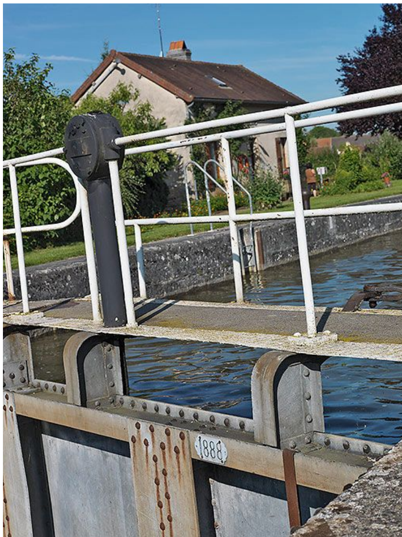
Détail des portes aval avec date portée 1888.
