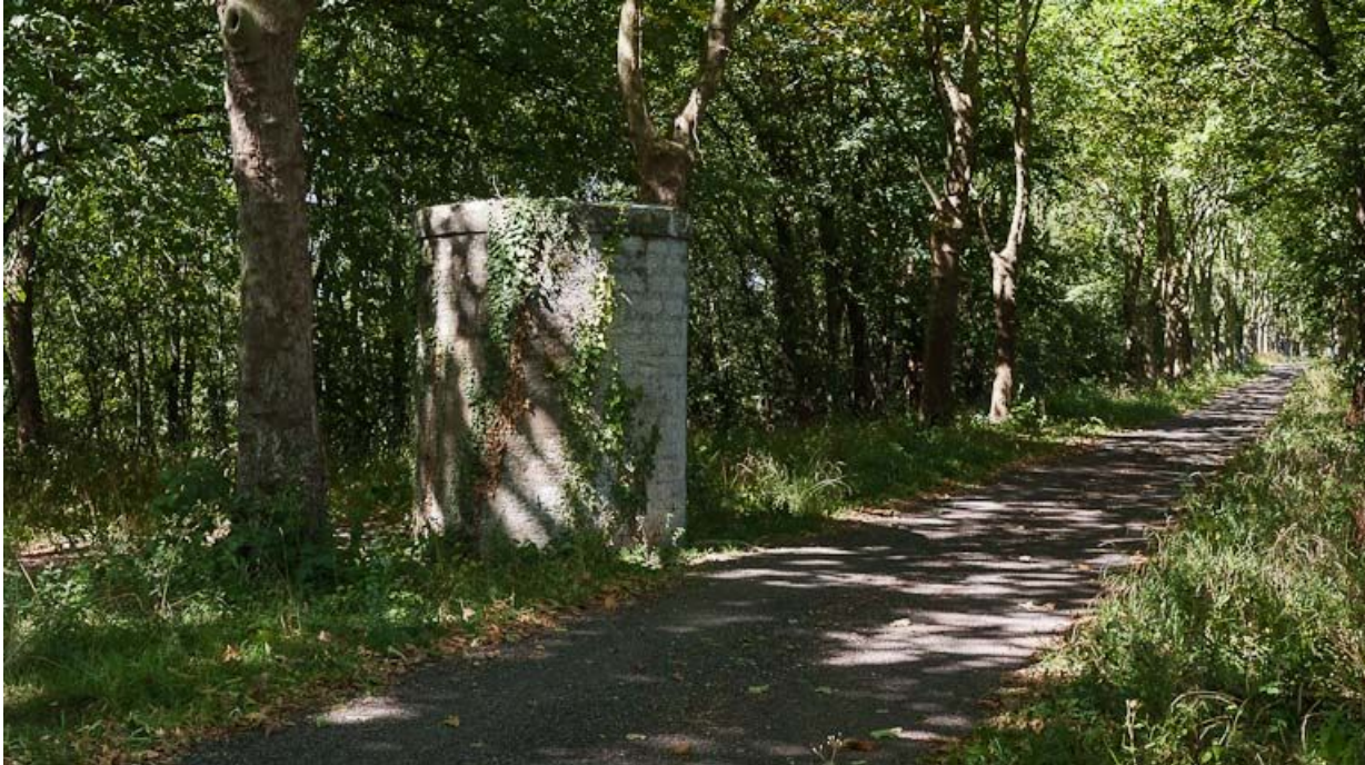
Vue d'un puits d'aération du tunnel.
