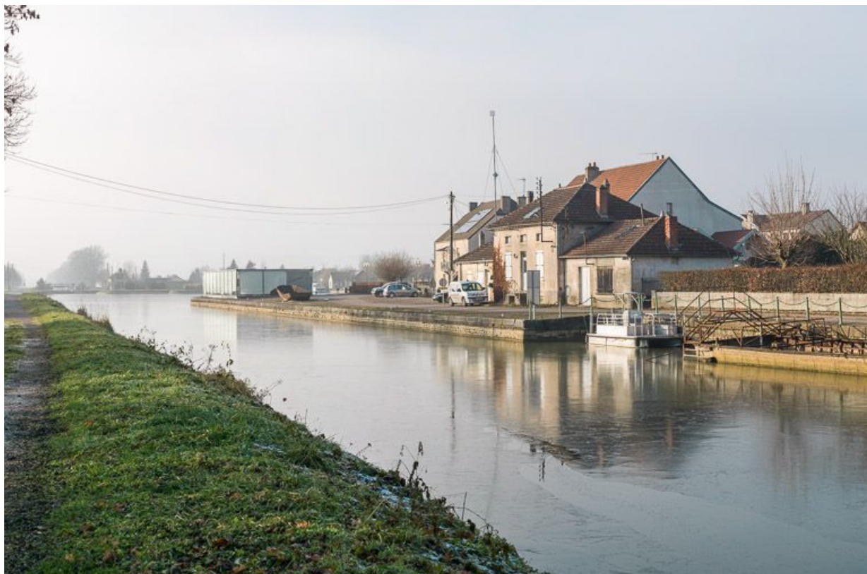
Vue d'amont. En arrière plan le centre d'interprétation et le port.
