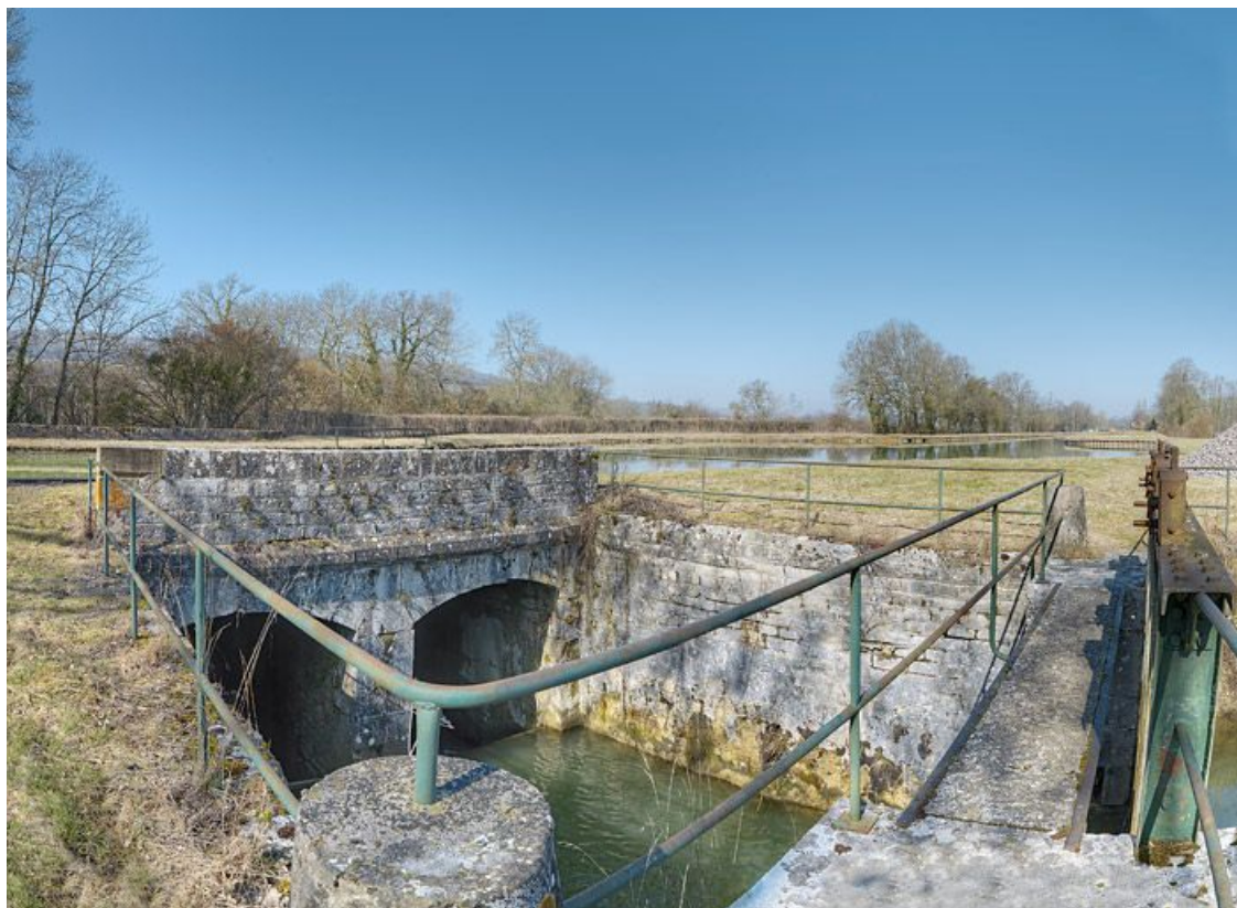
Arrivée de la Brionne vers le canal : vannes et aqueduc à deux arches.
