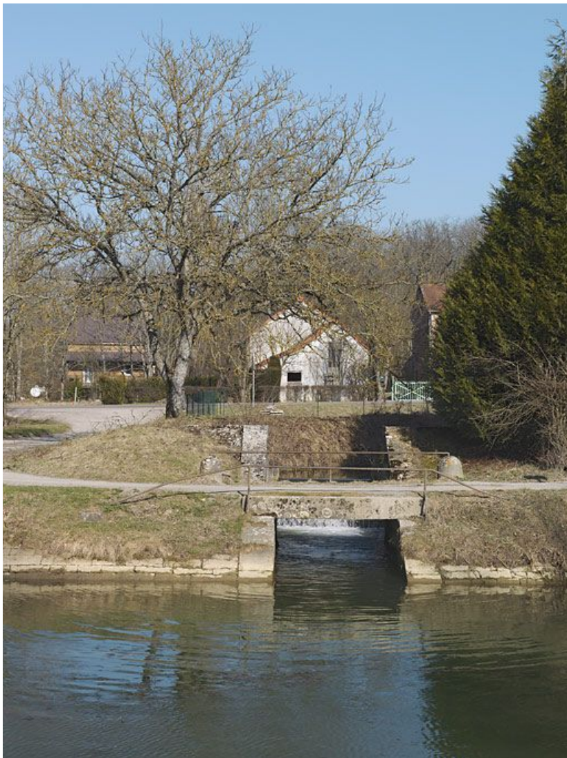
Entrée de la rigole d'alimentation dans le canal. 21, Gisse-le-Vieil, lieudit : bief 12 du versant Yonne
