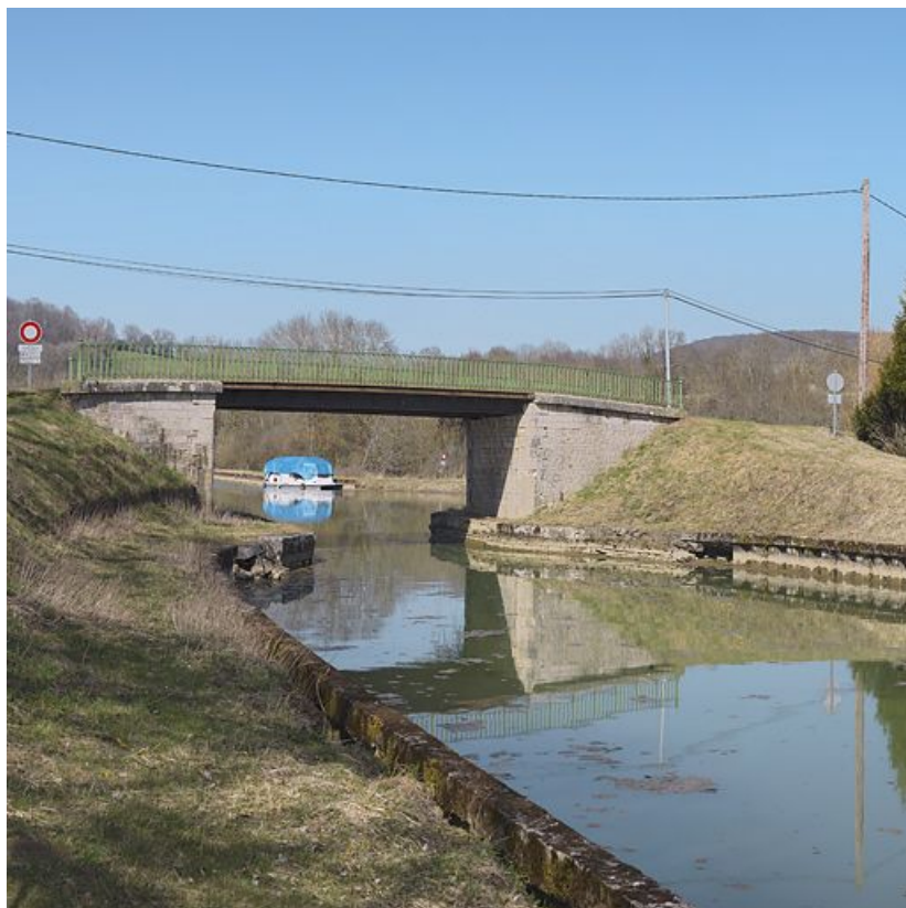
Vue d'ensemble du pont. Le port de Beurizot à l'arrière-plan.
