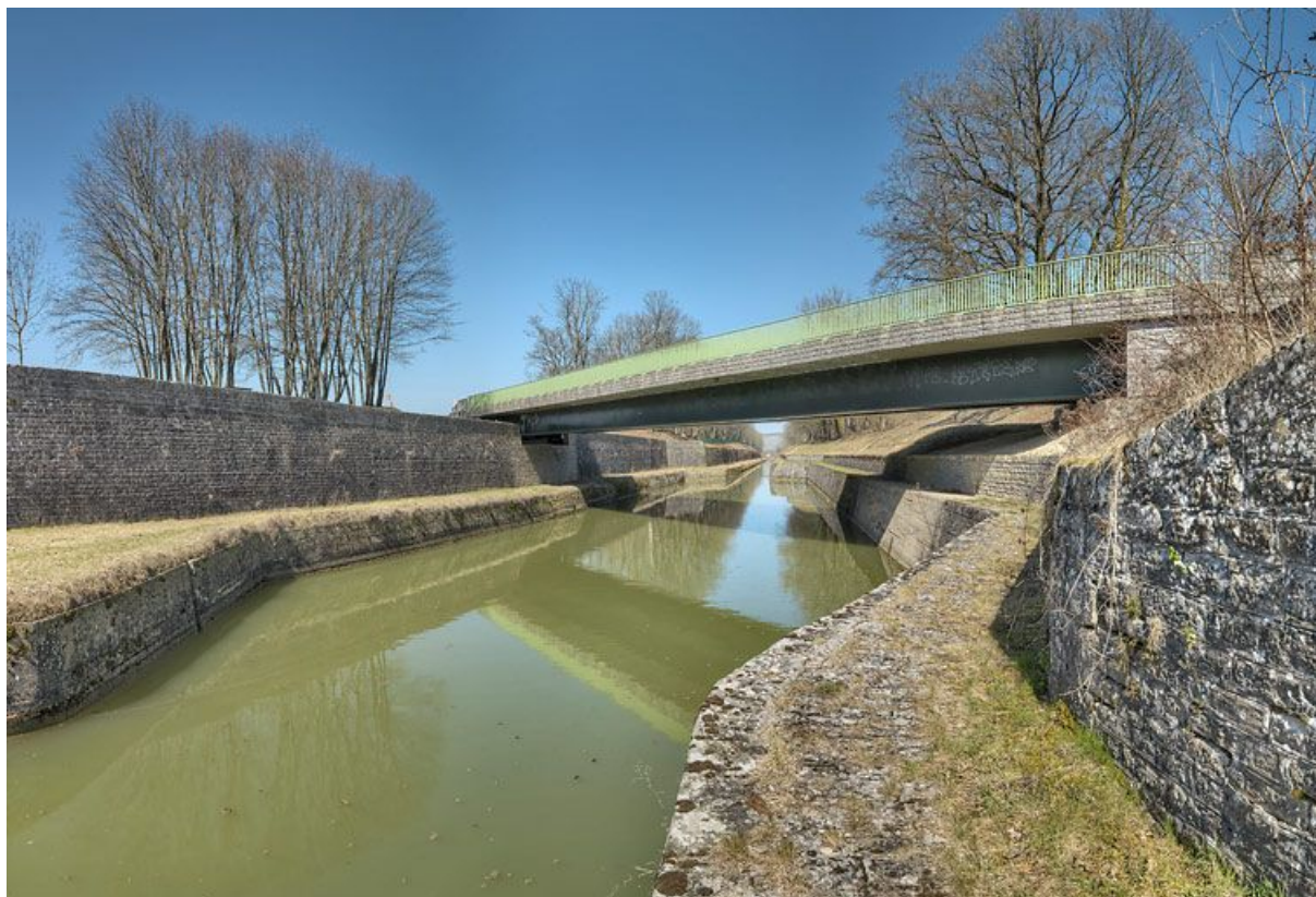
Vue d'ensemble du pont moderne : on distingue les différents niveaux de la tranchée.
