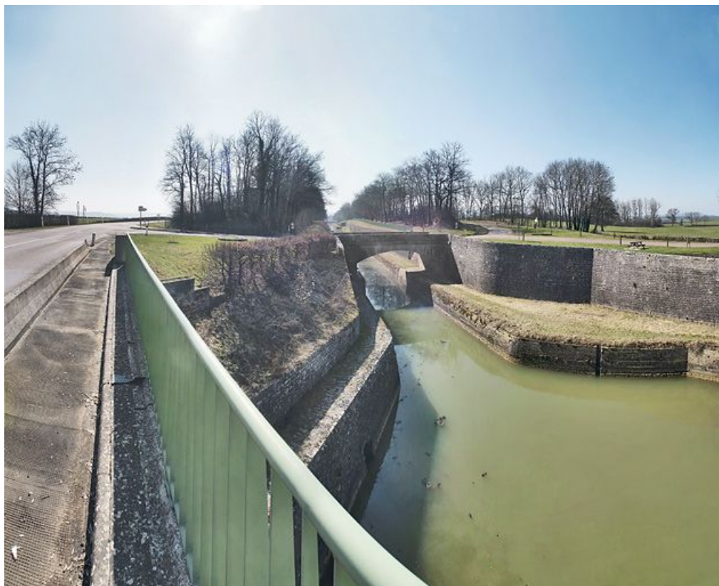
Le pont en pierre de l'aval. On voit les différents niveaux de la tranchée : canal, banquette de halage et sommet. 21, Saint-Thibault, lieudit : bief 13 du versant Yonne
