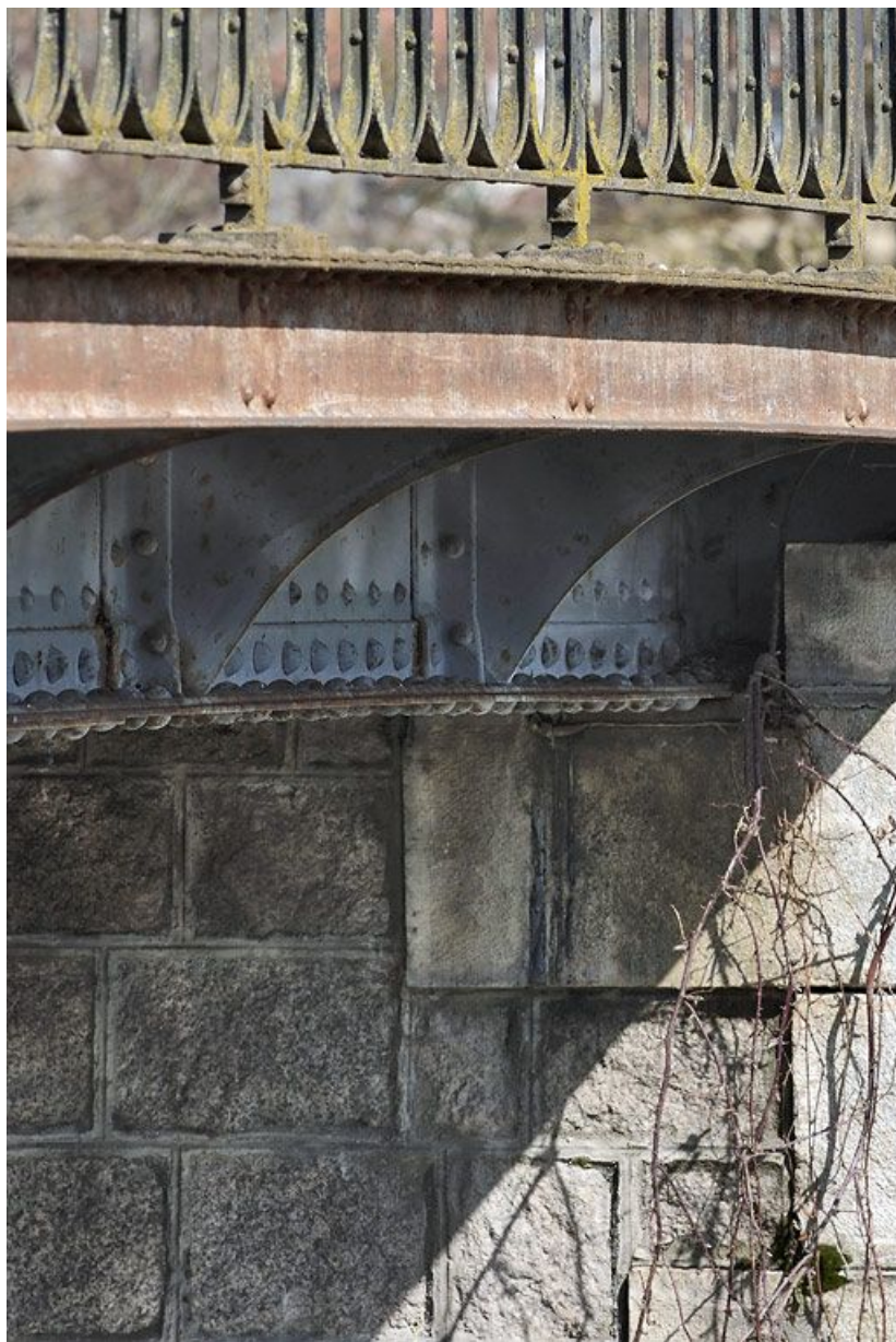
Le pont routier, détail du tablier métallique. 21, Clamerey, lieudit : bief 14 du versant Yonne
