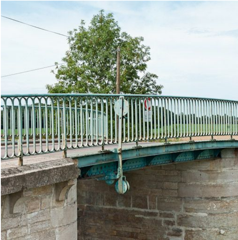
Détail du garde-corps avec la poulie.
