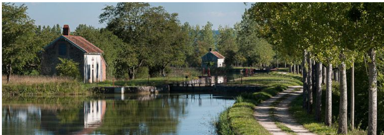
Vue du site d'écluse 37 Y depuis l'amont. A l'arrière-plan, vue du site d'écluse 38 Y 21, Pouillenay, lieudit : bief 37 du versant Yonne
