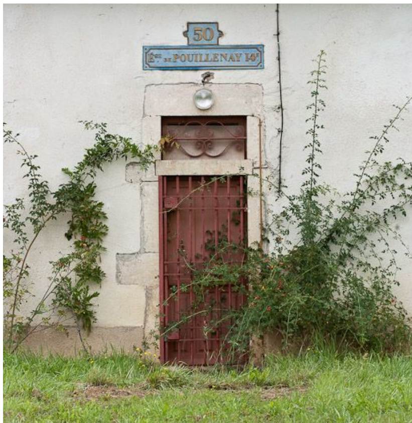
Détail de la porte d'entrée de la maison éclusière.
