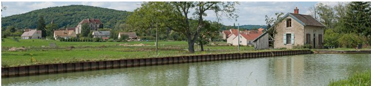
Vue du site d'écluse et du château de Venarey (IA21003512) à l'arrière-plan.
