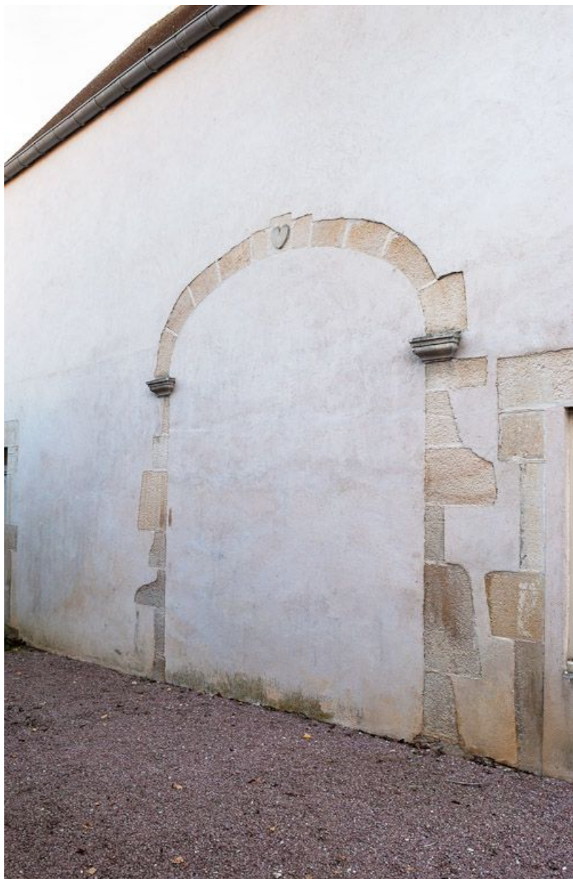
Ancien bûcher transformé en "salle d'asile" : porte charretière murée.
