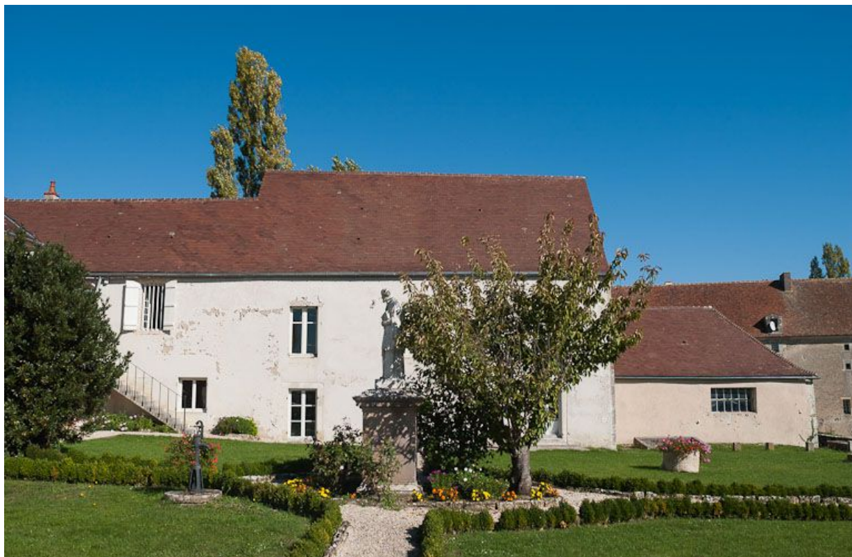
Jardin et vue partielle du bâtiment de l'apothicairerie, de l'ancienne "salle d'asile" et de l'ancien pressoir. 21, Moutiers-Saint-Jean, 8 place de l' Hôpital
