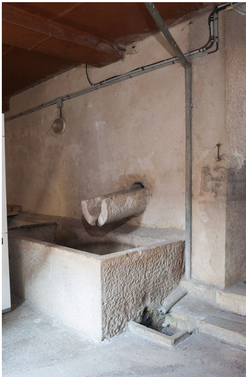
Corps de bâtiment transversal : buanderie à l'étage de soubassement.
