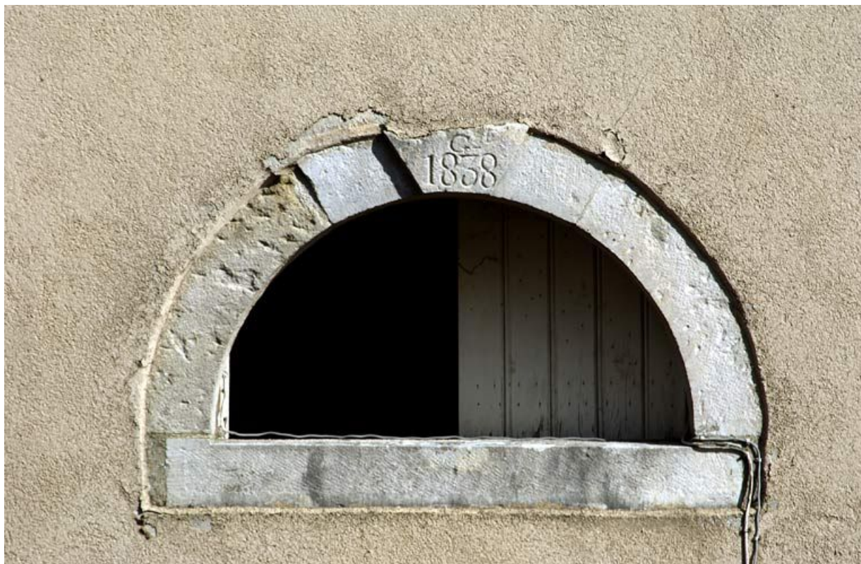
Corps de bâtiment à gauche de la cour principale : date gravée (mur pignon sud).
