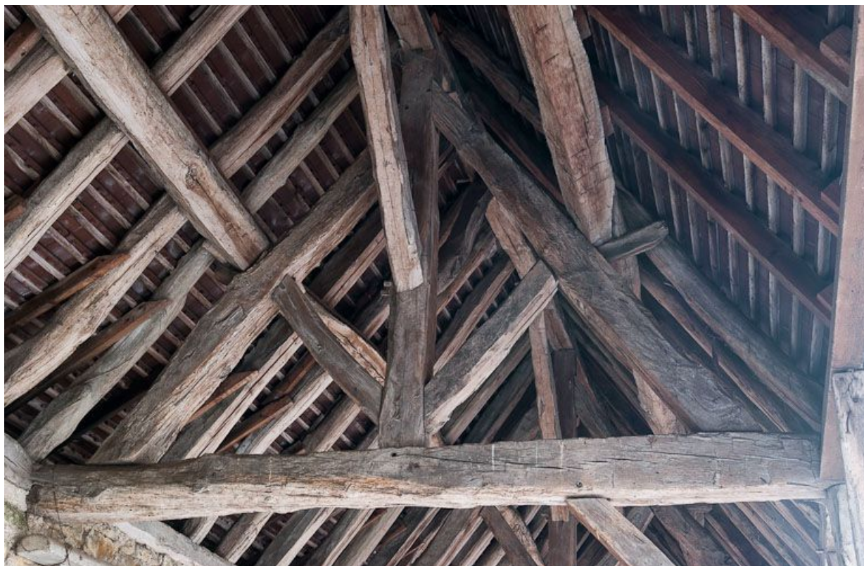
Cour latérale gauche : charpente du hangar.
