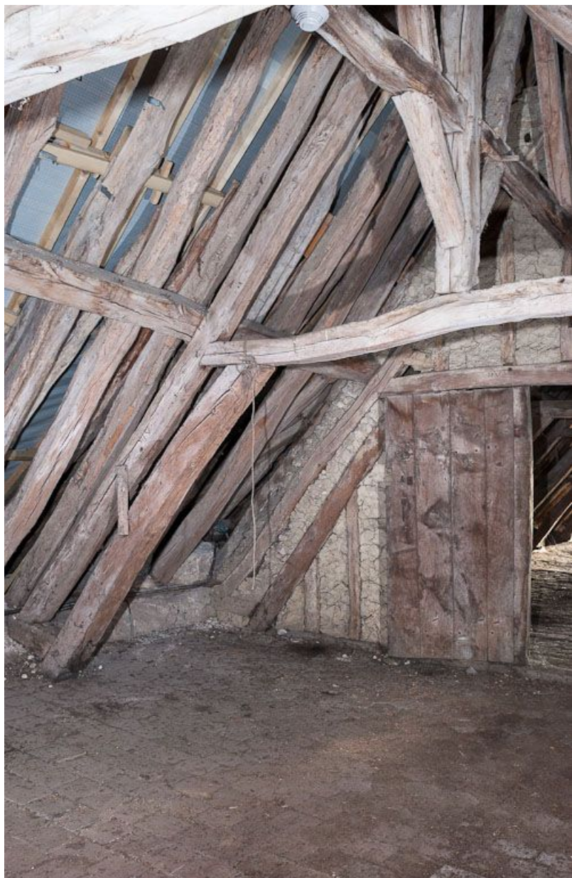
Corps de bâtiment principal : charpente (au-dessus de l'ancienne salle des femmes).
