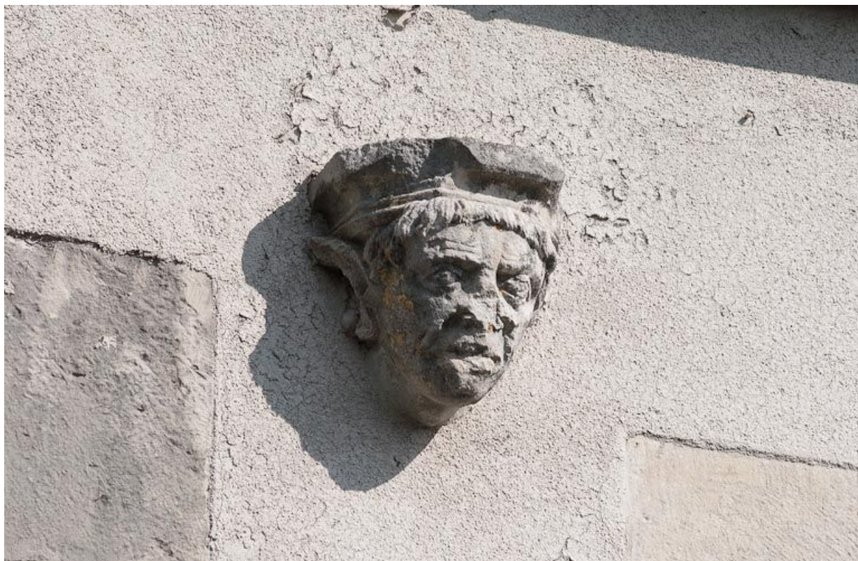
Corps de bâtiment principal : façade postérieure, sculpture en relief.
