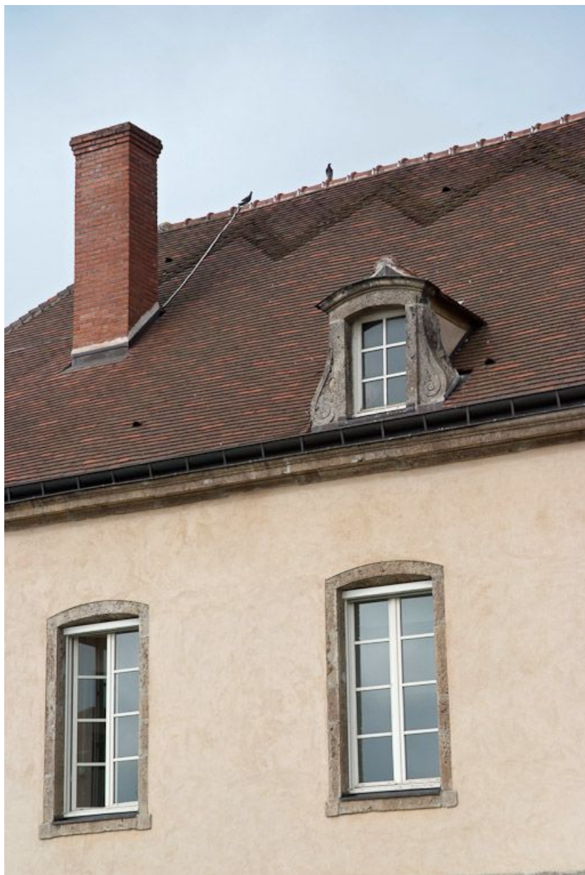
Façade postérieure du bâtiment principal : détail.
