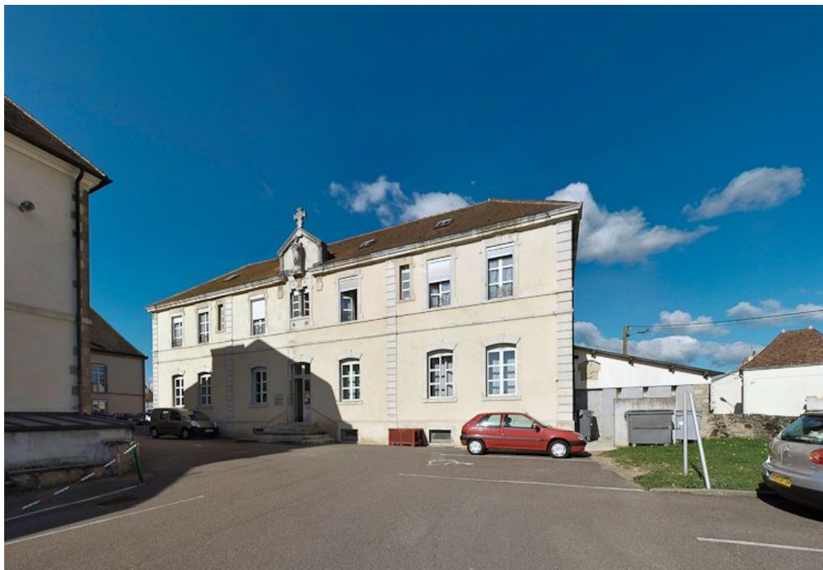
Ancien bâtiment des vieillards : façade. 21, Saulieu Courtépée
