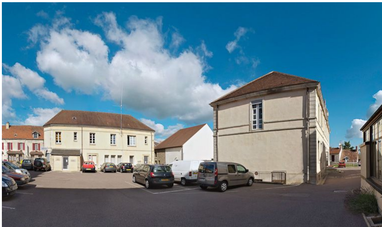
Bâtiment ouest, à gauche de l'entrée de la cour et élévation gauche de l'ancien bâtiment des vieillards. 21, Saulieu Courtépée
