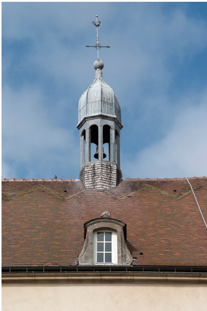
Façade postérieure du bâtiment principal : campanile et lucarne. 21, Saulieu Courtépée
