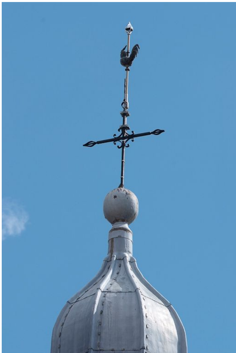
Détail du campanile. 21, Saulieu Courtépée
