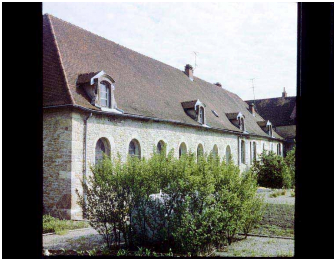
Vue du bâtiment principal.
