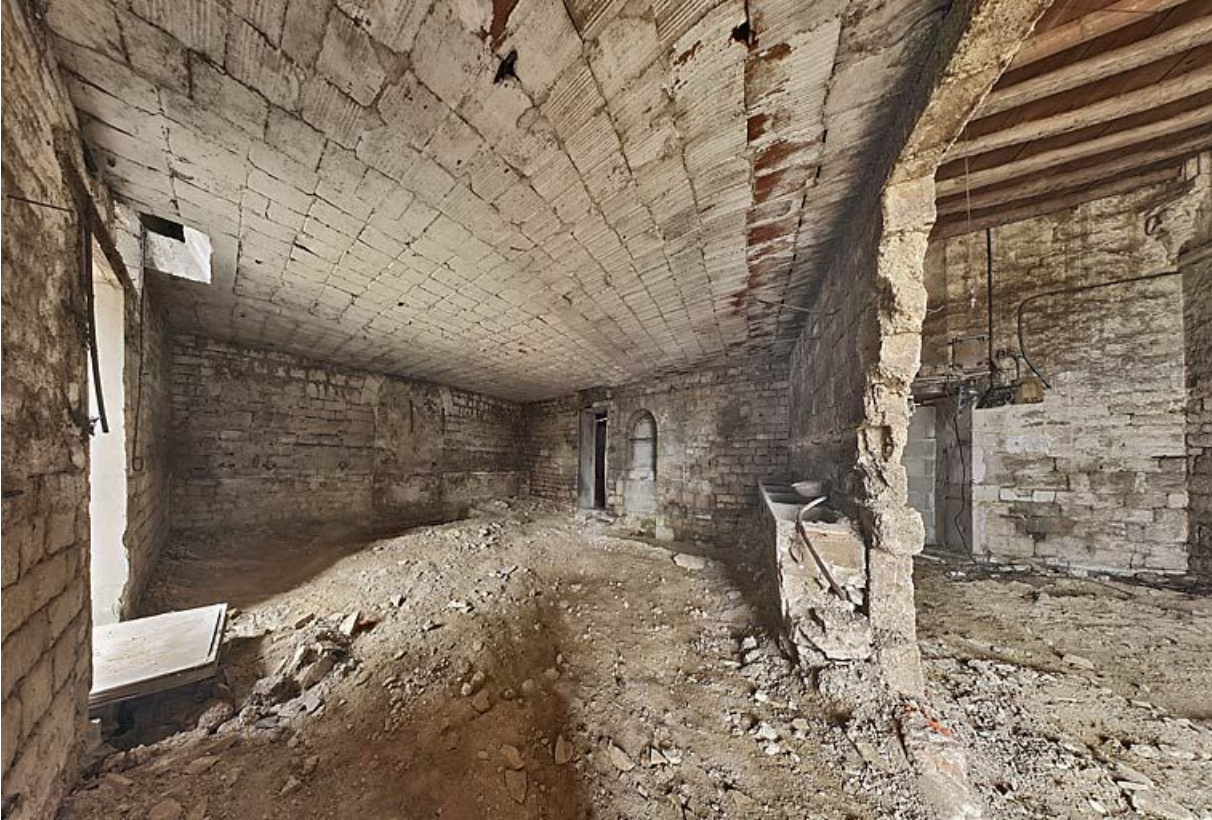
Ancienne chapelle : vue de la pièce derrière le portail.
