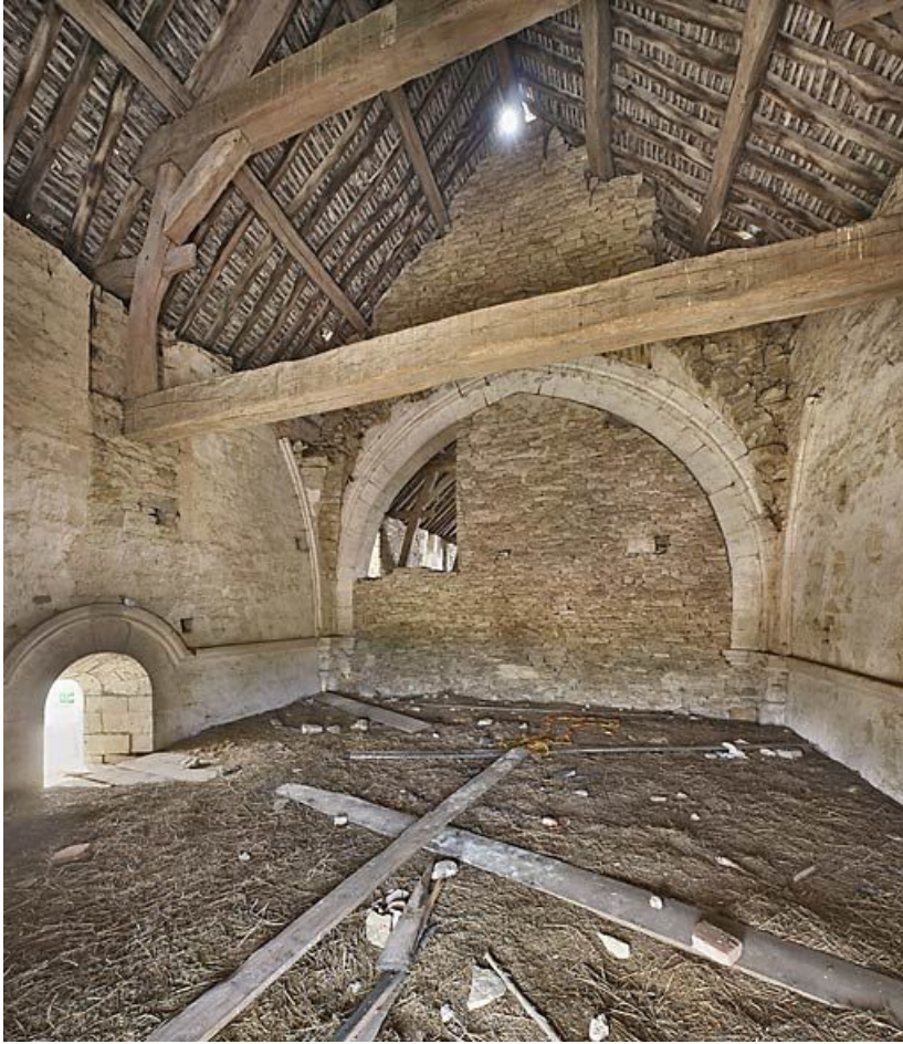
Ancienne chapelle : pièce aménagée à l'étage.
