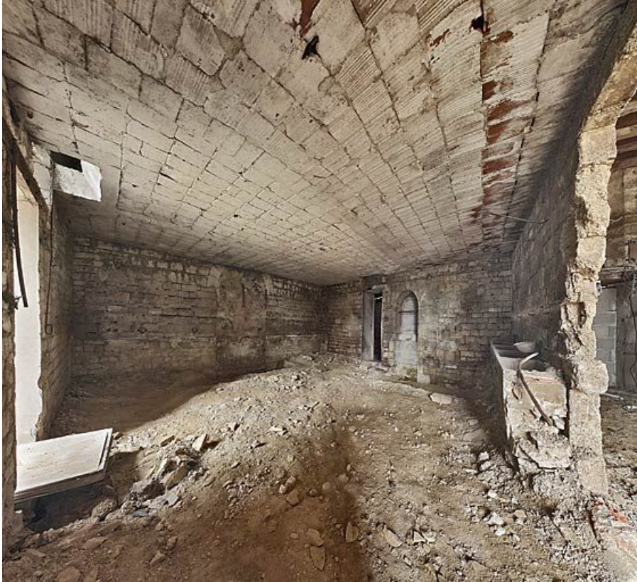
Ancienne chapelle : vue de la pièce derrière le portail.
