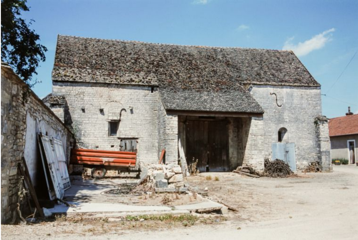
Vue de la chapelle : façade latérale.
