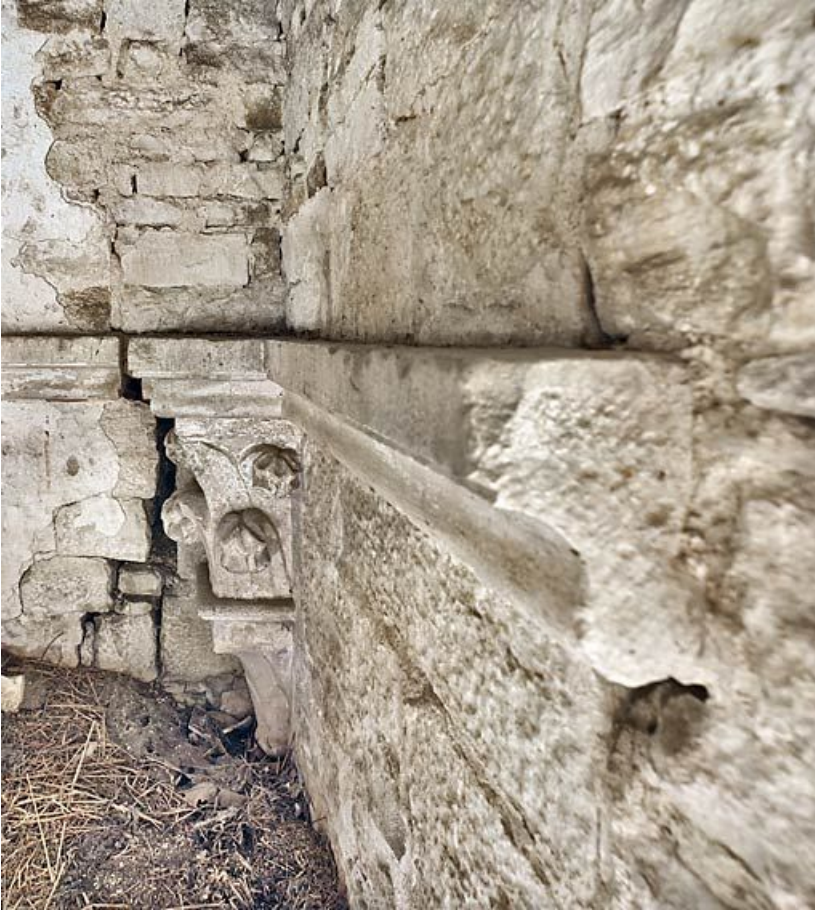
Ancienne chapelle : pièce aménagée à l'étage.
