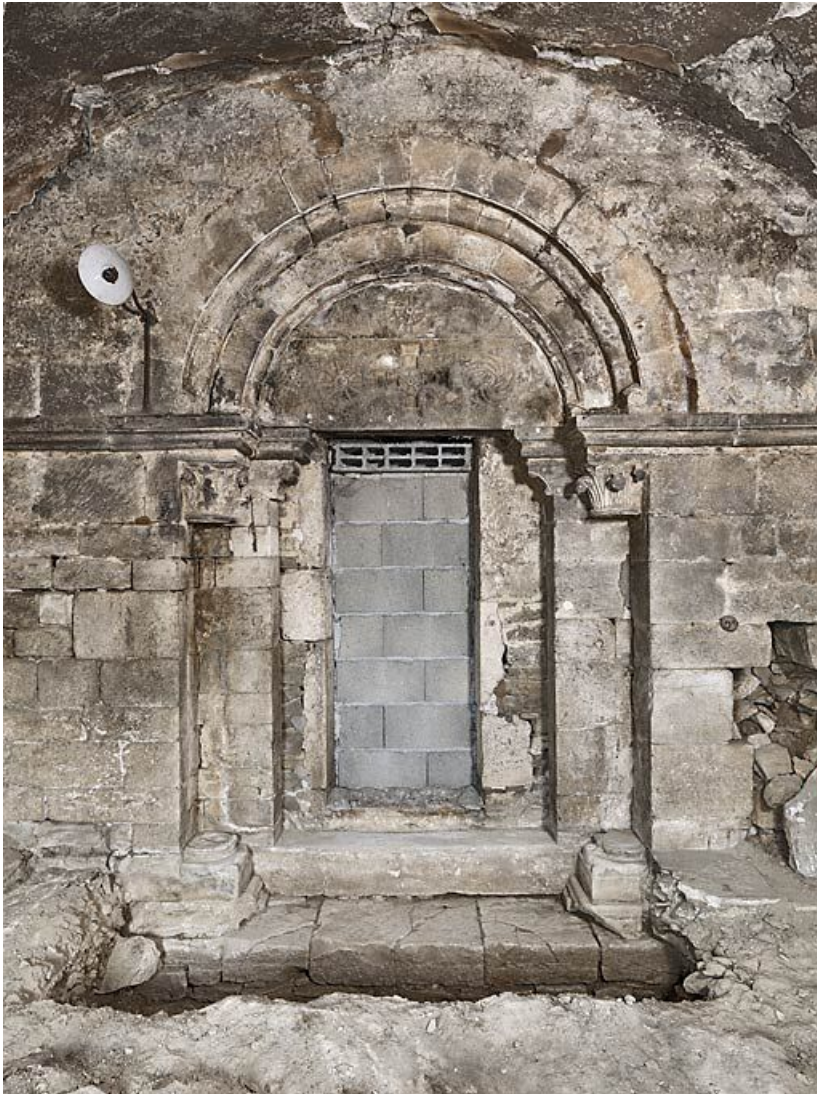
Porterie : porte donnant sur la cour vue de l'intérieur.
