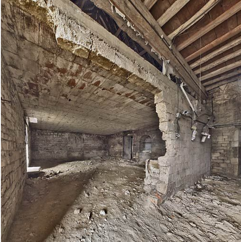
Ancienne chapelle : vue de la pièce derrière le portail.
