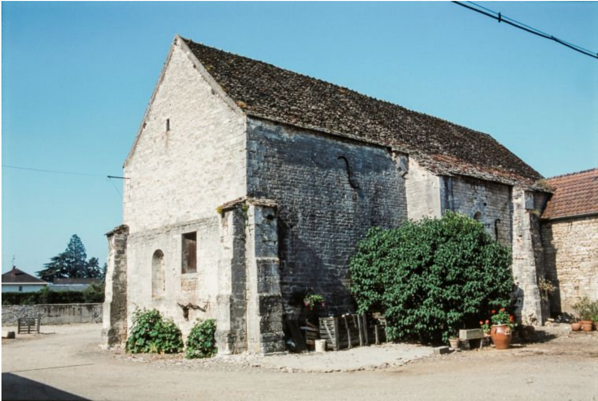
Vue du chevet et de la façade latérale.
