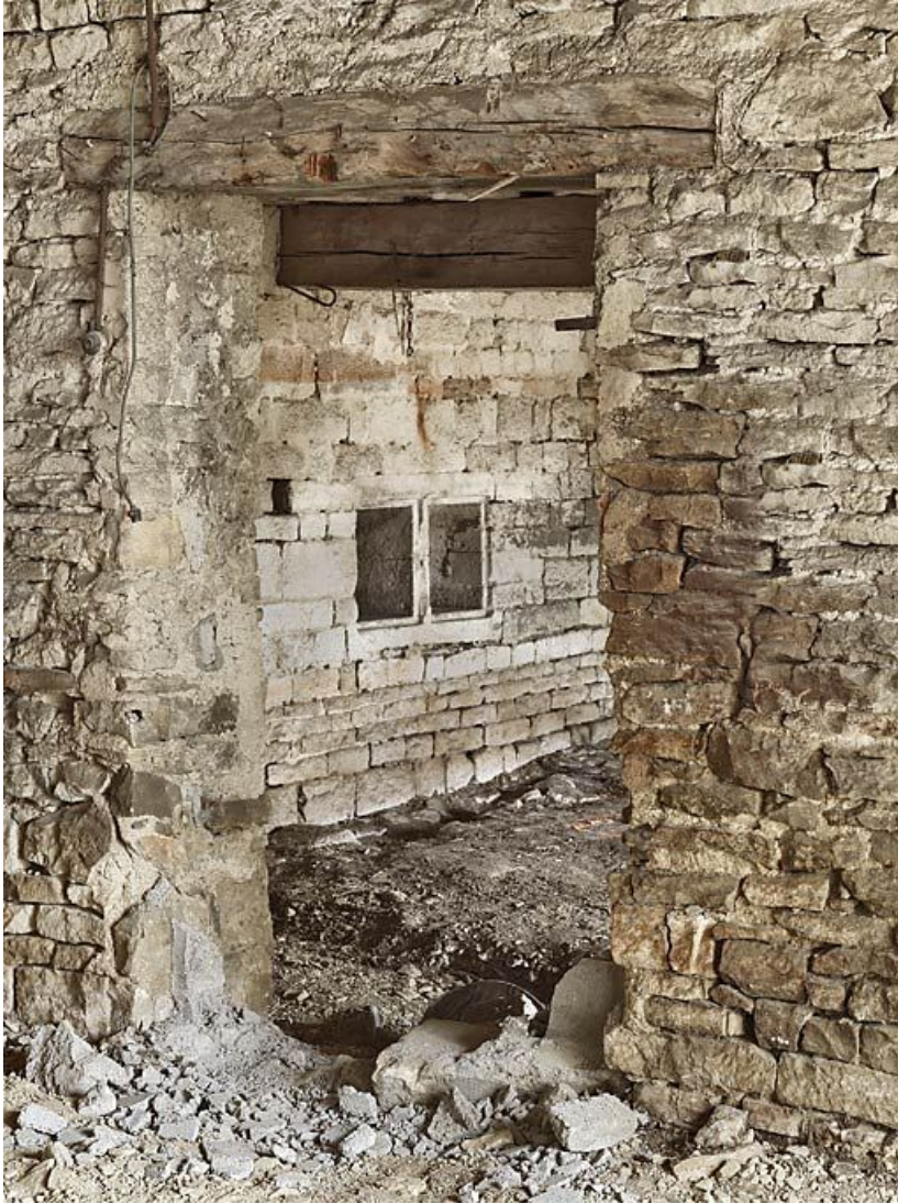
Ancienne chapelle : pièce donnant côté cour, vue depuis la pièce médiane. 21, Meursault R.N.74, lieudit : l' Hôpital de Meursault
