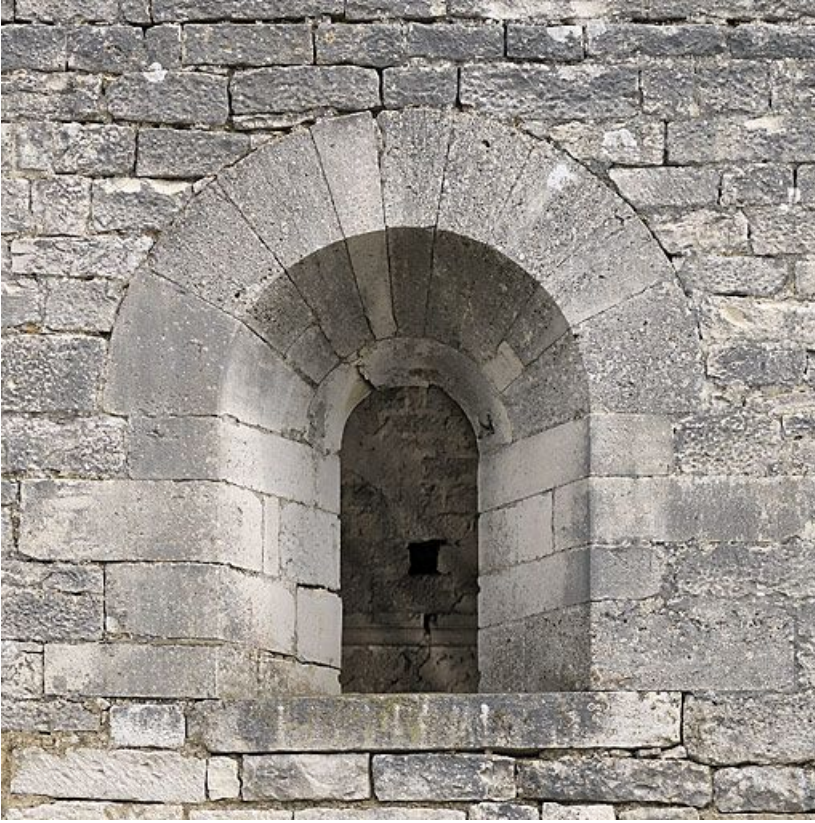
Détail de la façade postérieure : baie.
