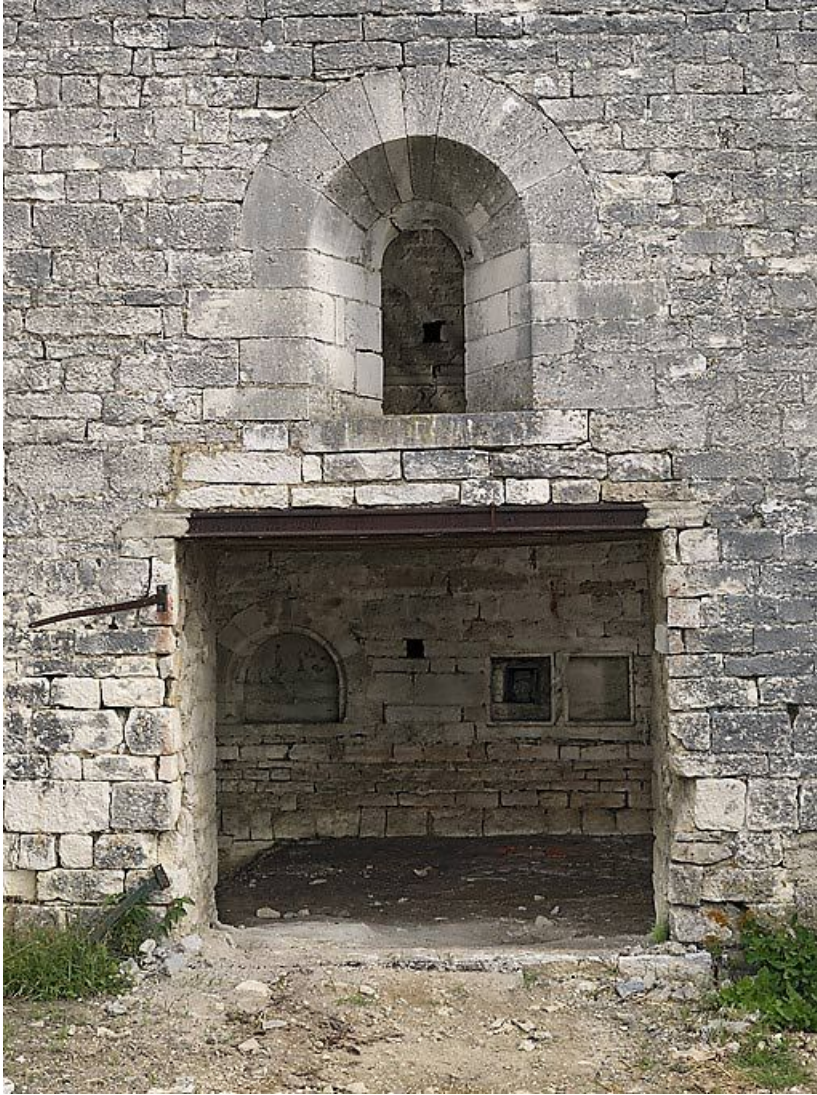
Détail de la façade postérieure : baie et ouverture.
