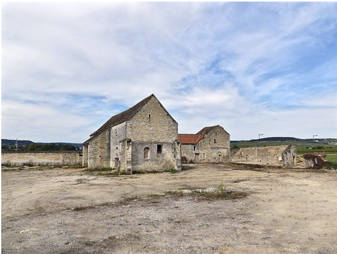
Vue d'ensemble vers le Nord.
