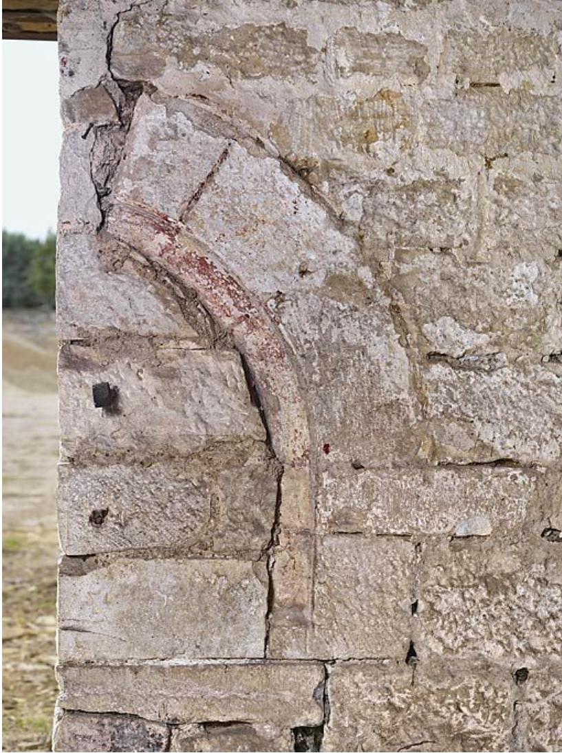
Ancienne chapelle : pièce donnant côté cour : arc dans la maçonnerie.
