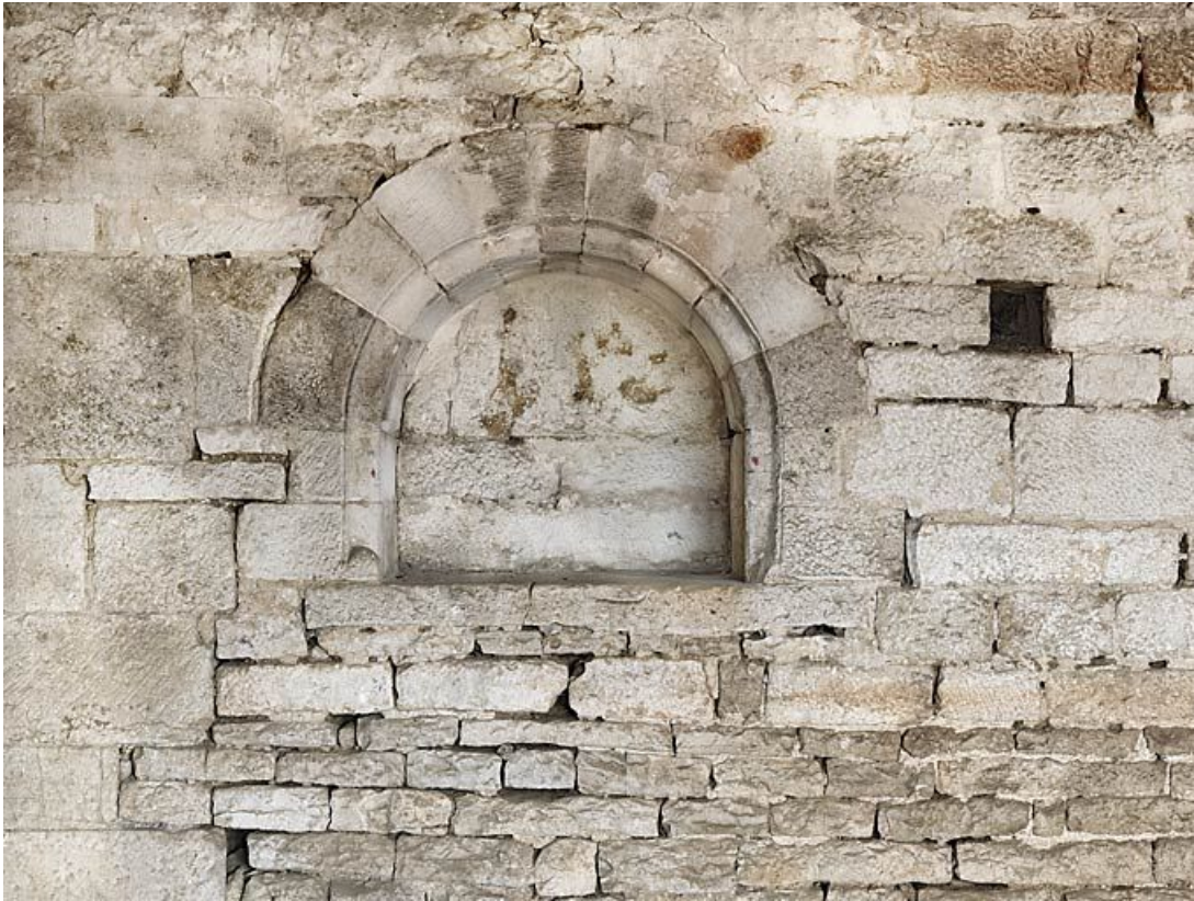
Ancienne chapelle : pièce donnant côté cour ; arc. 21, Meursault R.N.74, lieudit : l' Hôpital de Meursault
