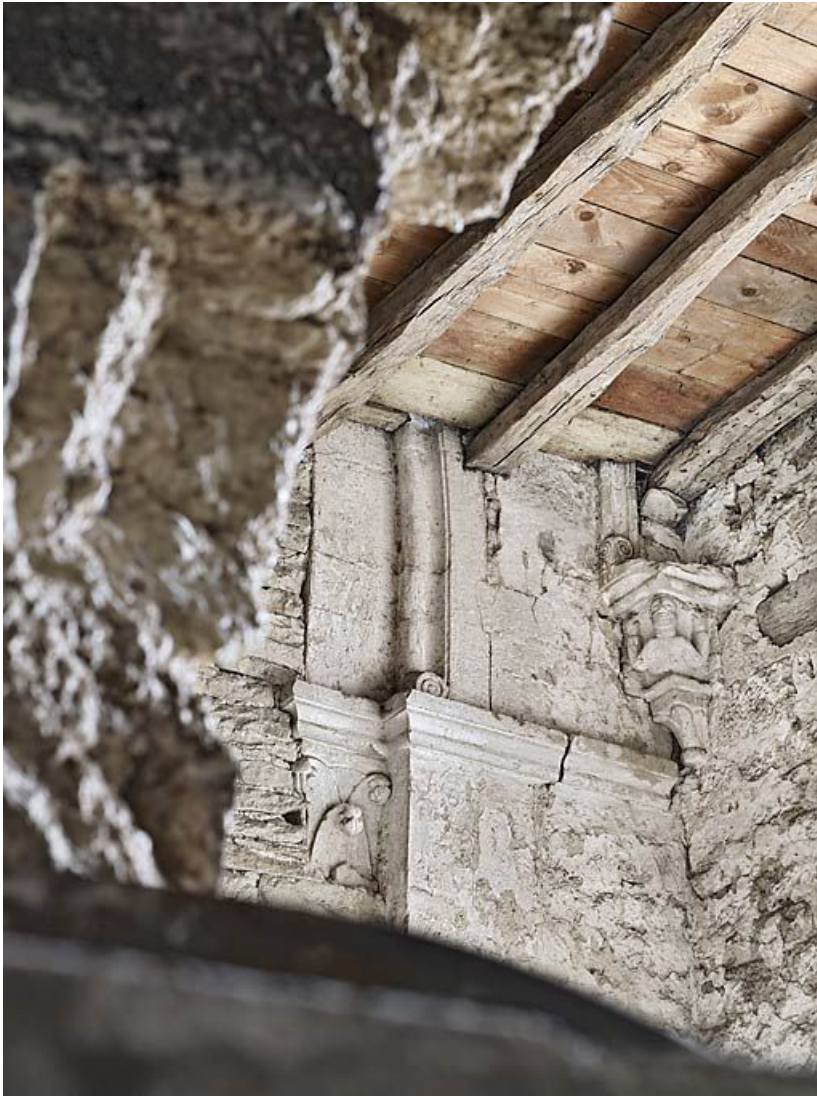
Ancienne chapelle : vue de la pièce médiane ; décor et maçonnerie.
