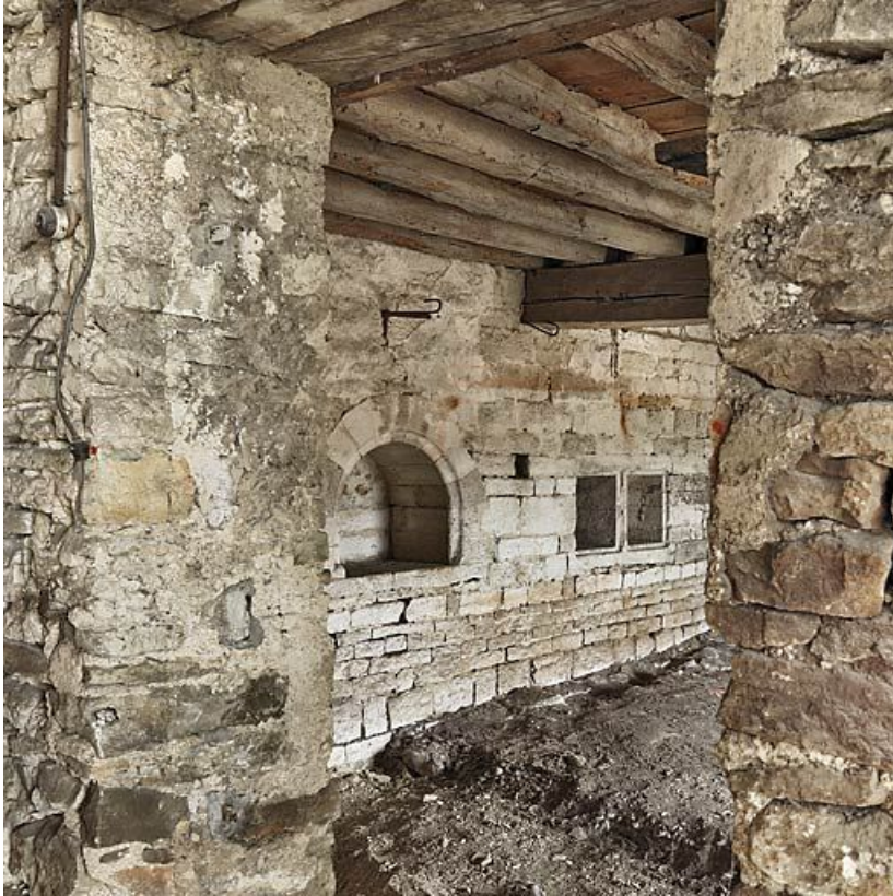
Ancienne chapelle : pièce donnant côté cour, vue depuis la pièce médiane.
