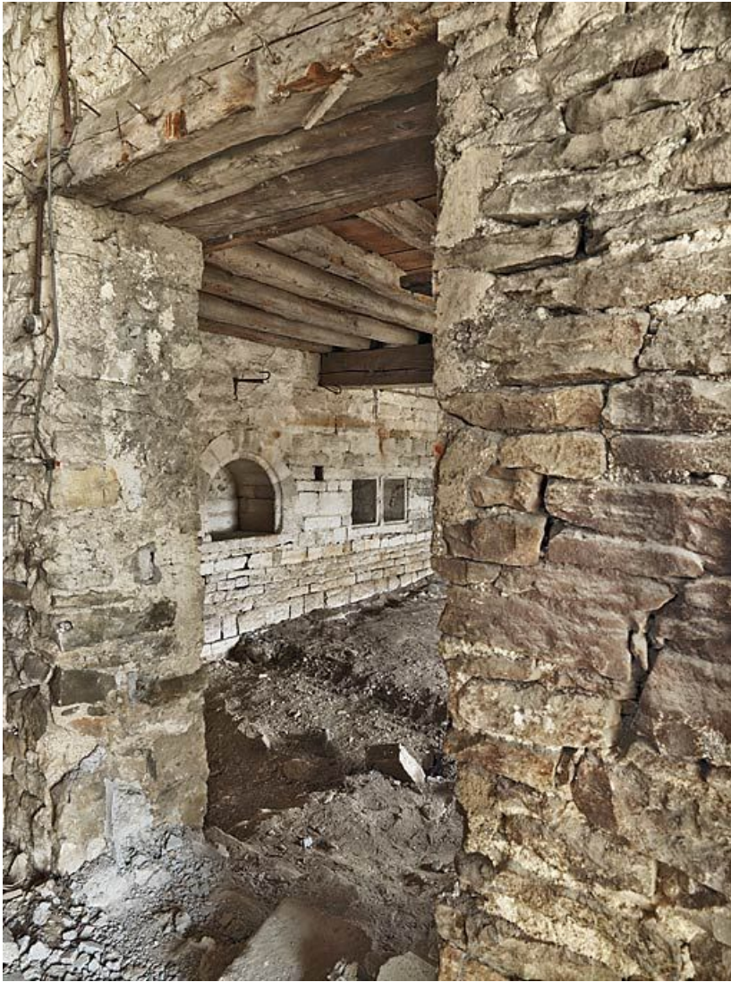
Ancienne chapelle : pièce donnant côté cour, vue depuis la pièce médiane.
