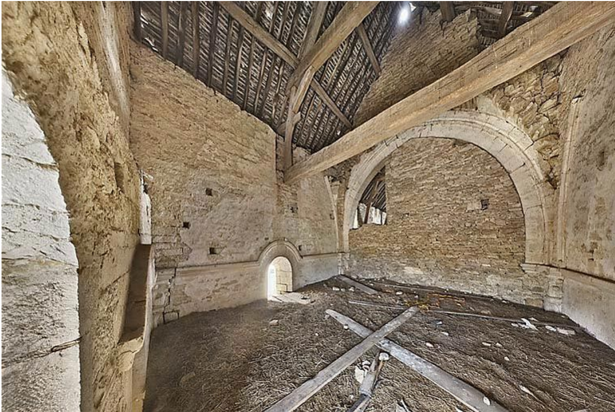
Ancienne chapelle : pièce aménagée à l'étage.
