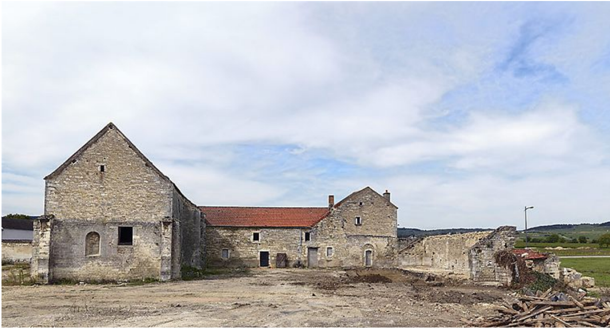
Vue d'ensemble vers le Nord-Ouest.
