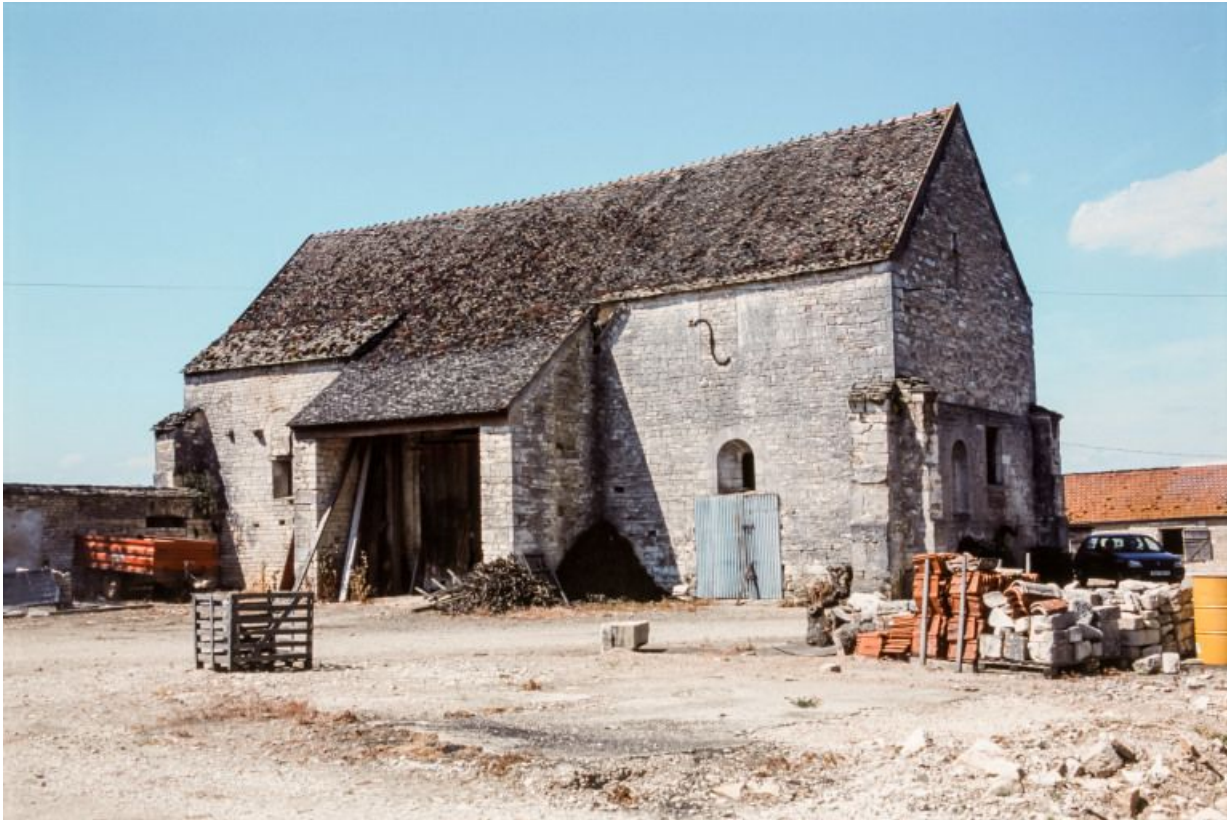
Vue de la chapelle : façade latérale.
