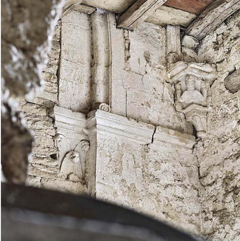
Ancienne chapelle : vue de la pièce médiane ; décor et maçonnerie.
