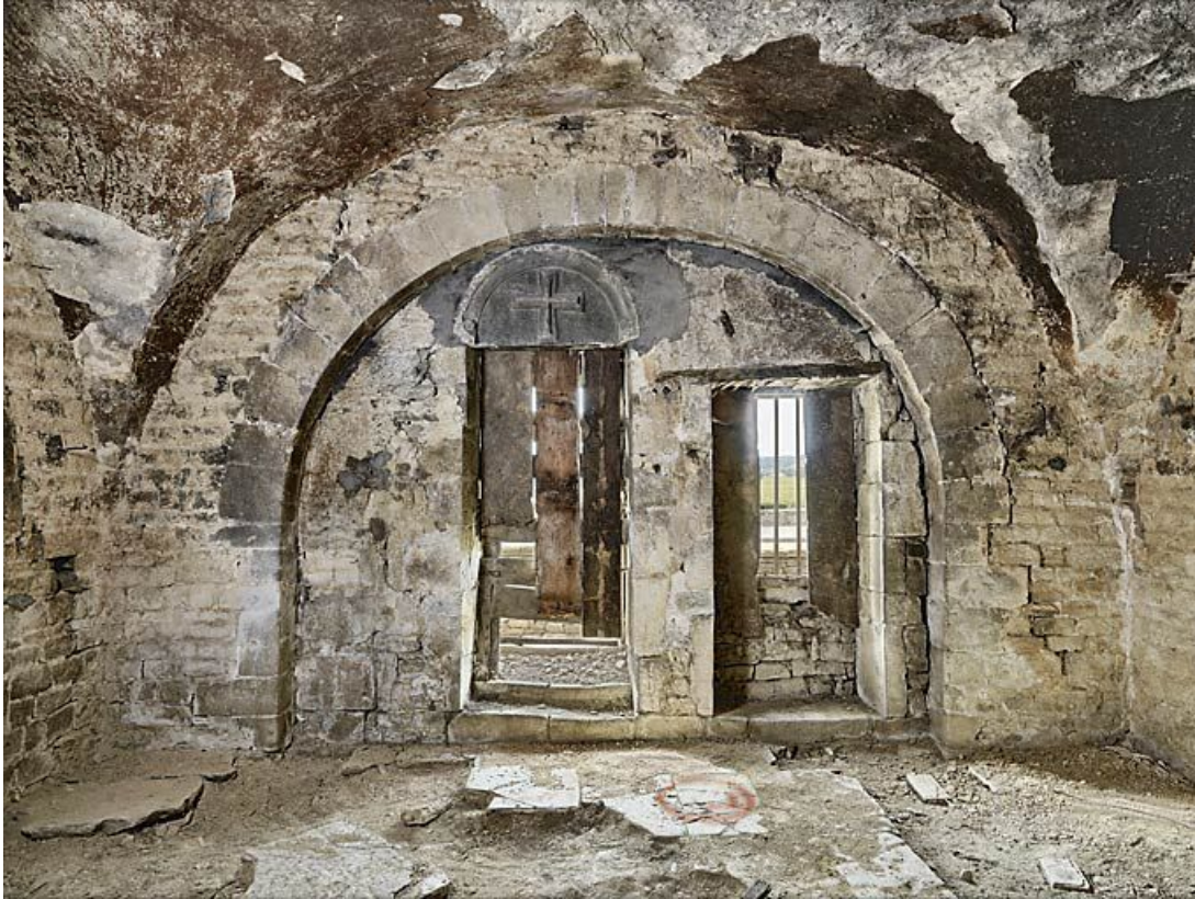
Porterie : porte et baie donnant sur la rue.
