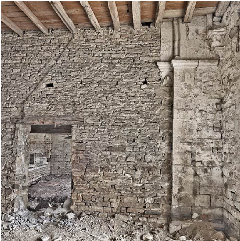
Ancienne chapelle : vue de la pièce médiane ; pilier.
