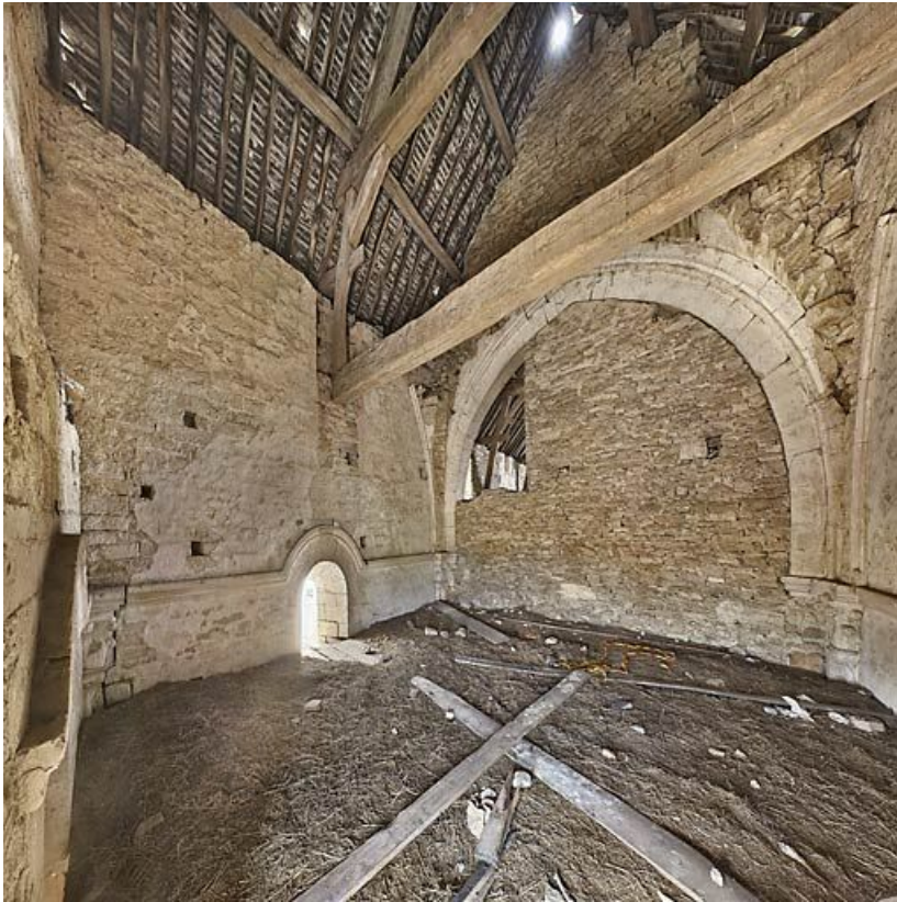
Ancienne chapelle : pièce aménagée à l'étage.
