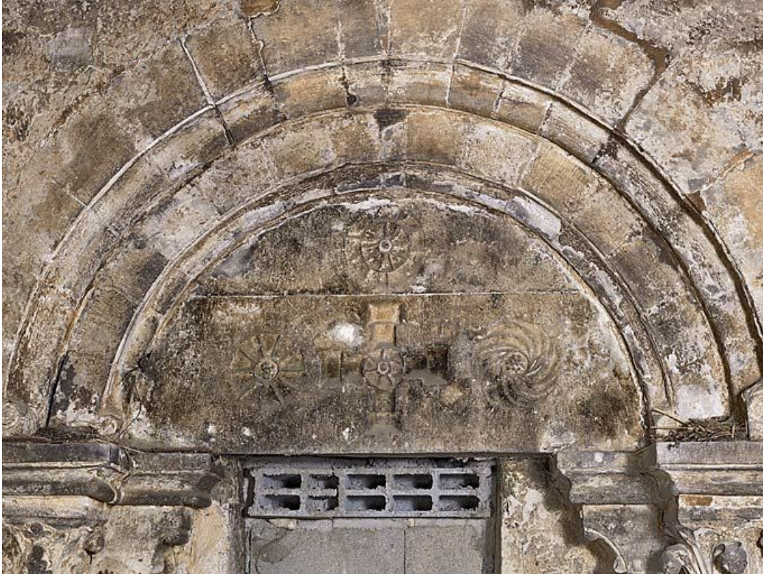
Porterie : détail de la porte donnant sur la cour vue de l'intérieur.
