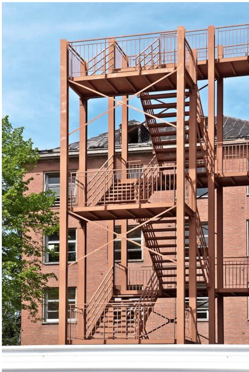
Bâtiment hospitalier, escalier de secours. 21, Dijon Stade
