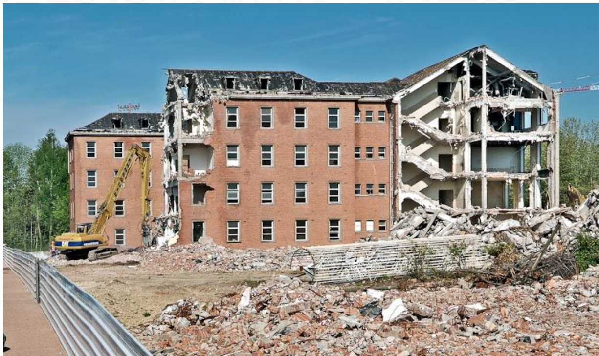
Bâtiment hospitalier en cours de démolition. 21, Dijon Stade
