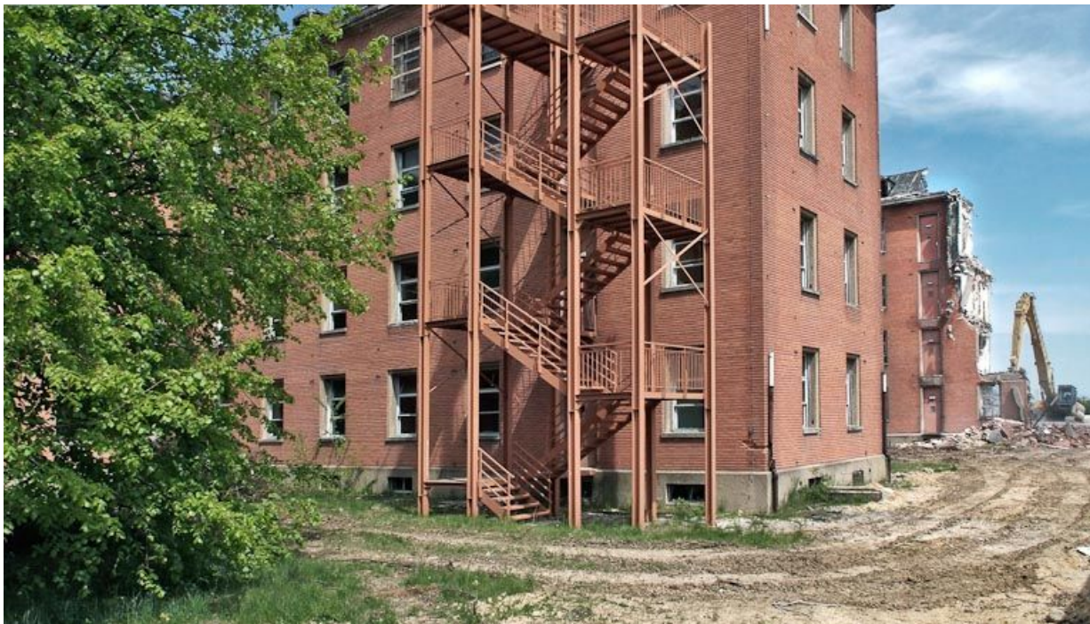
Bâtiment hospitalier en cours de démolition.
