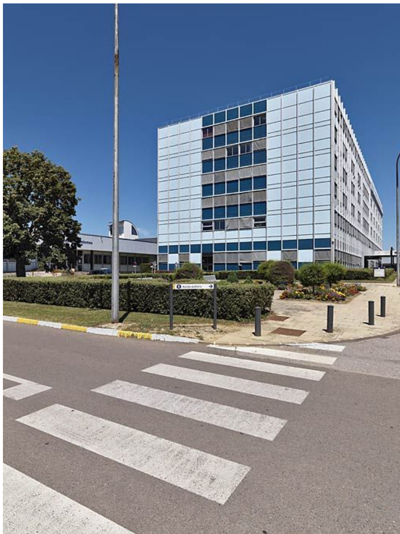
Bâtiment principal, vue d'ensemble de trois-quarts.
