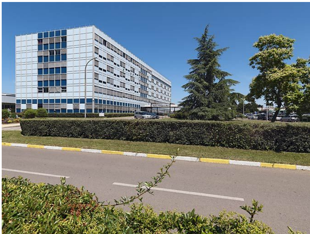
Bâtiment principal, vue d'ensemble de trois-quarts.
