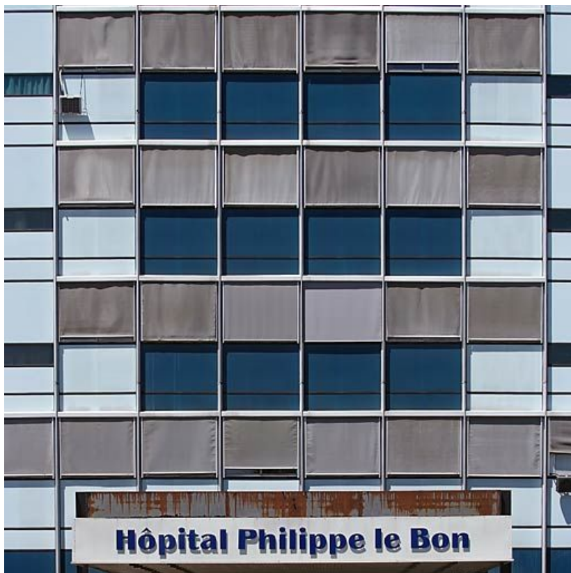
Bâtiment principal, détail de la façade.
