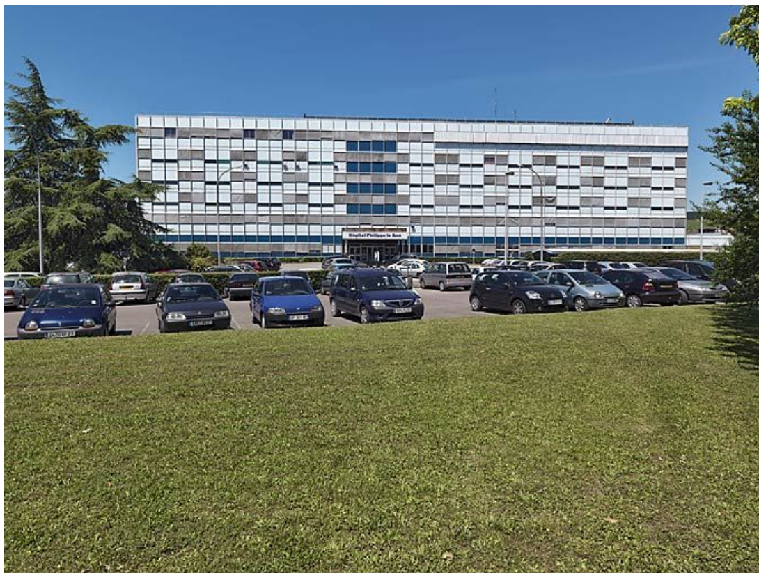
Bâtiment principal, façade.
