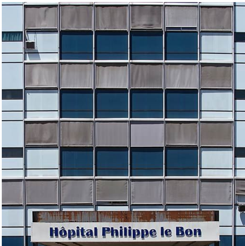
Bâtiment principal, détail de la façade.
