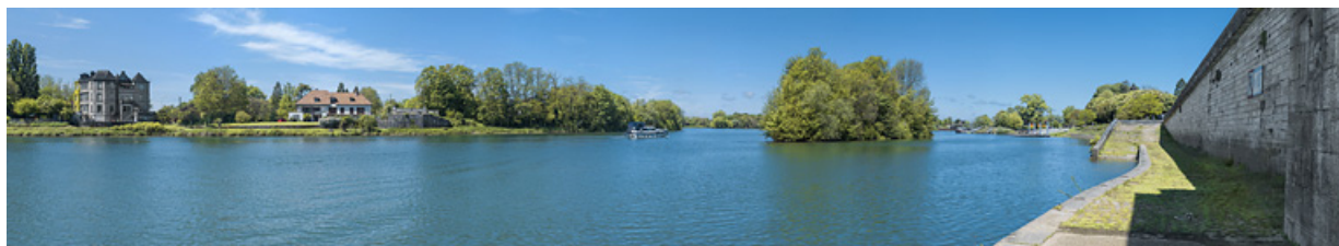
Panorama de la Saône à hauteur du passage de l'ancien pont : on distingue à gauche les vestiges de la culée. 21, Seurre, lieudit : PK 187
