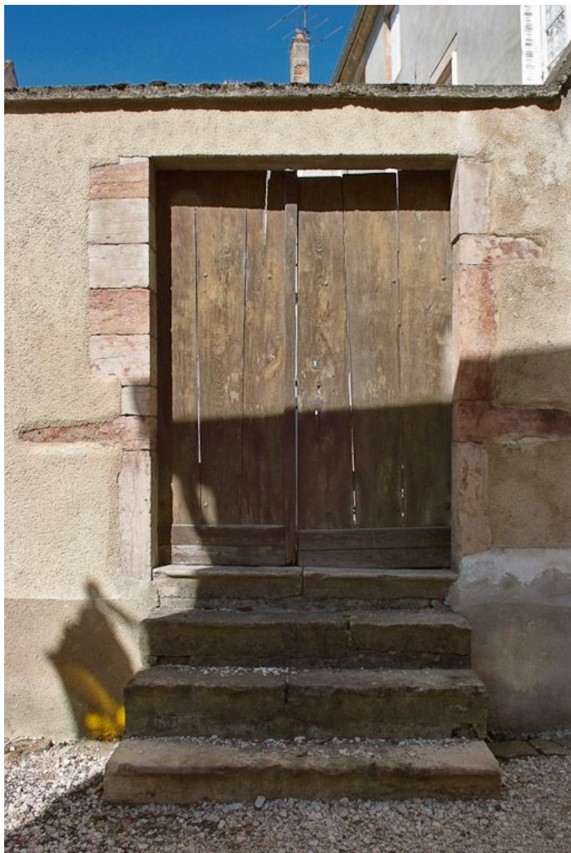
Porte du mur de clôture est de la cour.
