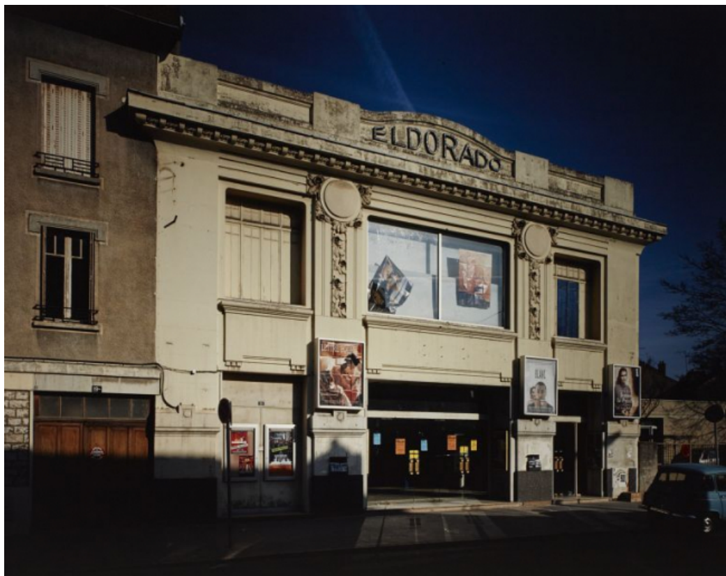
Vue d'ensemble de la façade en 1994.
