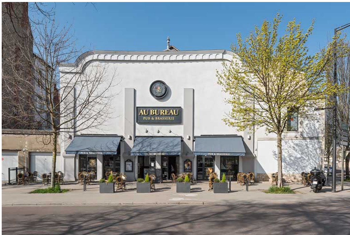
Façade antérieure. 21, Dijon
