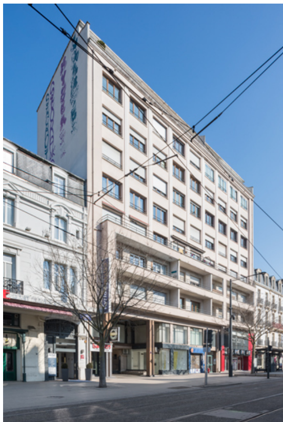
Immeuble rue Maréchal Foch : façade antérieure, de trois quarts gauche.
