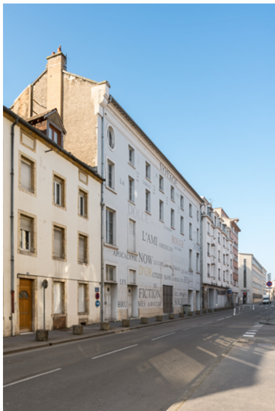
Batiment d'origine rue des Perrières : façade antérieure, de trois quarts gauche.
