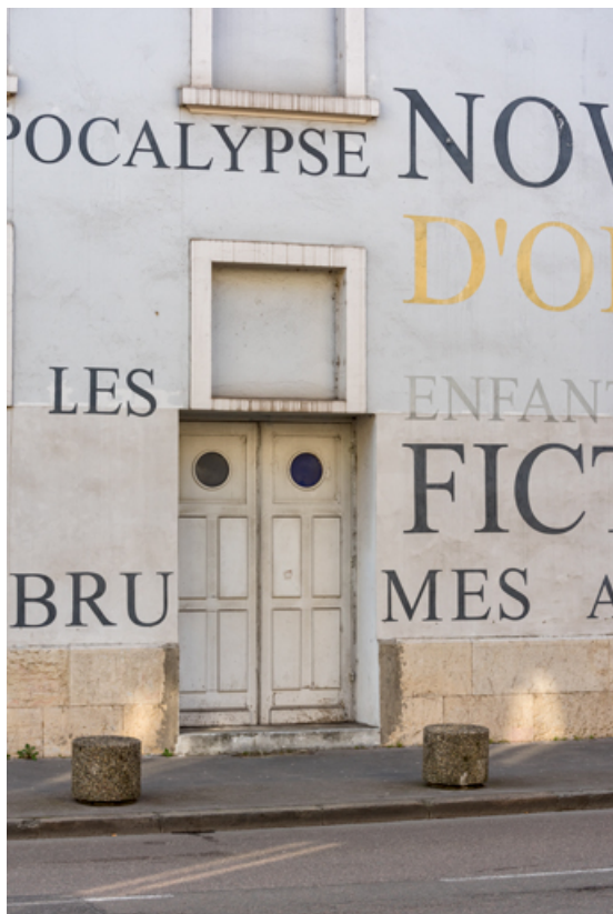
Batiment d'origine rue des Perrières, façade antérieure : porte.
