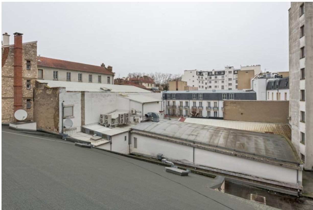
Bâtiments vus depuis le toit de la salle 2. De gauche à droite : bâtiment d'origine rue des Perrières, salle 3 et immeuble rue Maréchal Foch.
