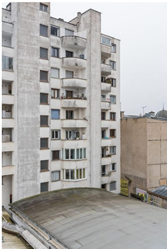
Immeuble rue Maréchal Foch : façade postérieure. Au premier plan, toiture de la salle 3. 21, Dijon, 16-20 bis avenue du Maréchal Foch
