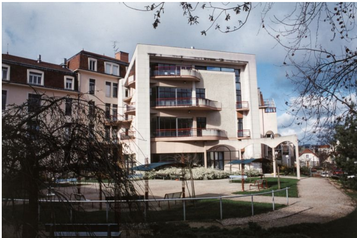
extension de bâtiment d'origine, élévation nord sur le parc
