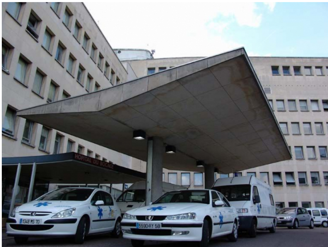
Entrée principale de l'hôpital et son auvent, vue en contre-plongée. 21, Dijon, 2 boulevard Maréchal-de-Lattre-de-Tassigny
