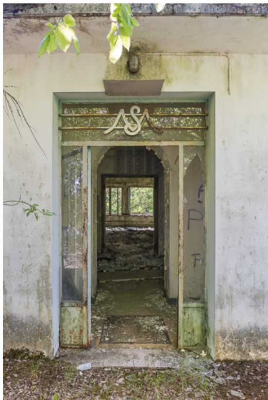
Bâtiment principal, façade postérieure, porte d'entrée.
