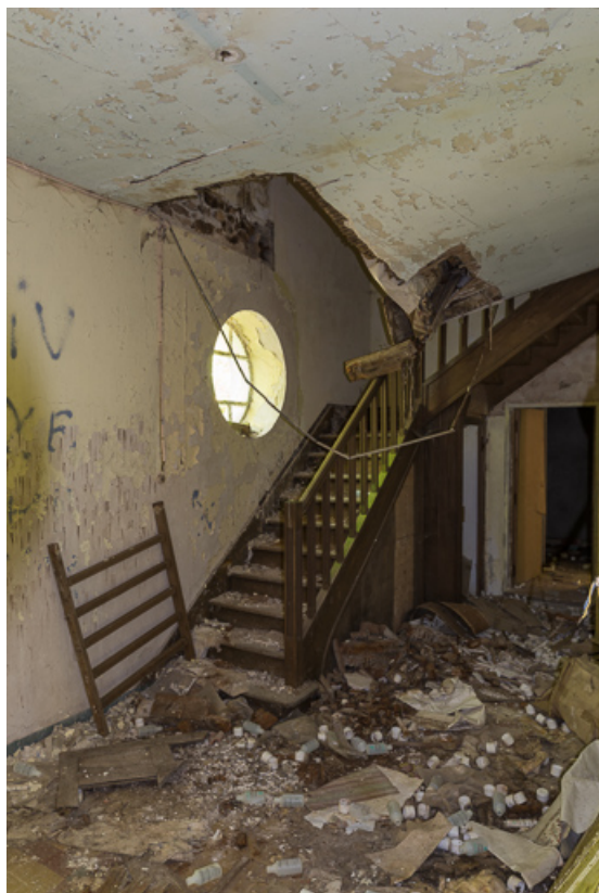
Bâtiment principal, vue intérieure du hall avec l'escalier en bois de l'édifice d'origine. 21, R.D.17 Magnien rue de la Source, lieudit : écart de Maizières
