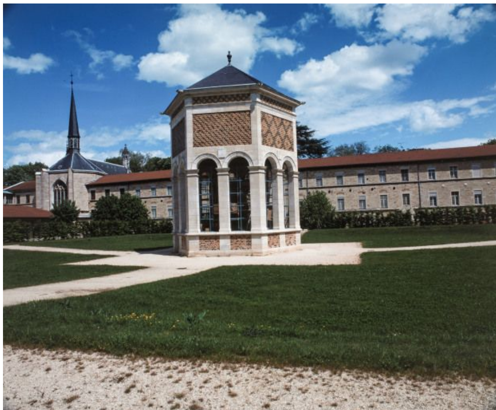
Aile droite du bâtiment construit par l'architecte Pierre-Paul Petit, et édicule abritant le Puits de Moïse au premier plan. 21, Dijon, 1 boulevard Chanoine Kir
