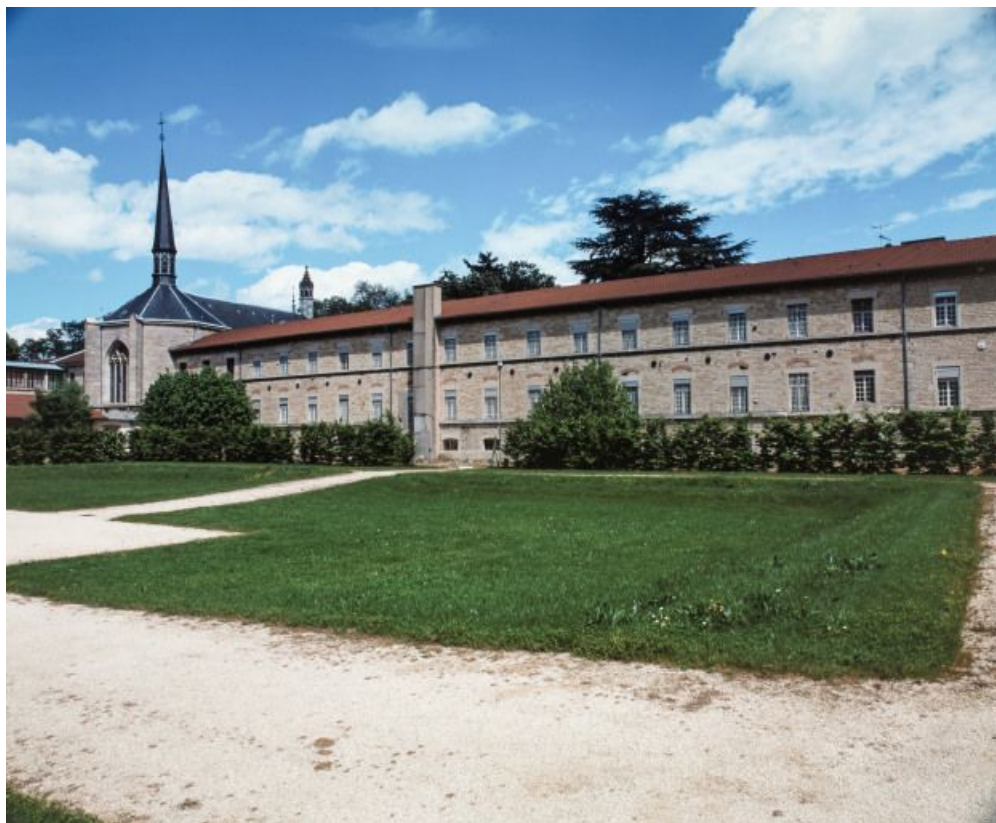
Aile droite du bâtiment construit par l'architecte Pierre-Paul Petit.
