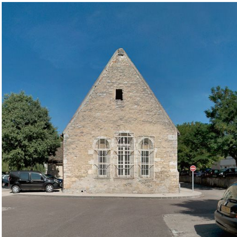
Élévation postérieure (chevet de l'ancienne chapelle).
