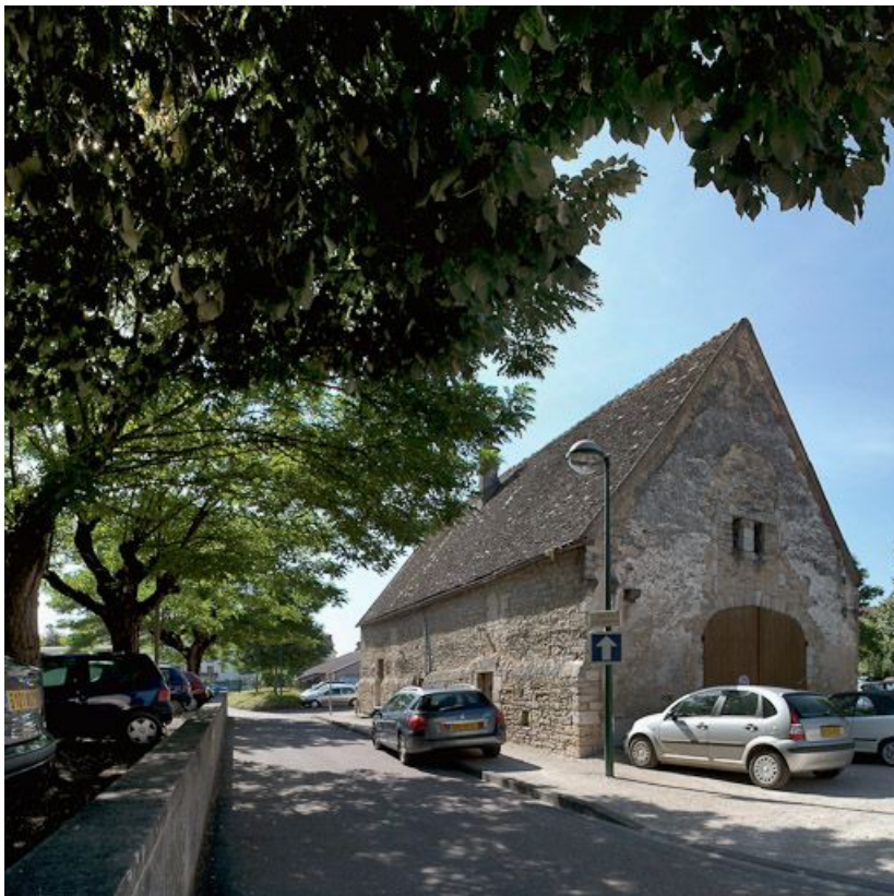
Façade antérieure et élévation gauche. 21, Beaune Moulin-Saint-Jacques
