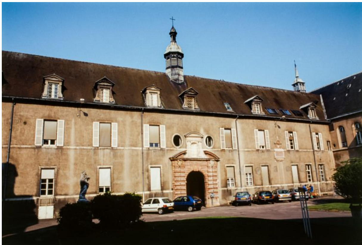
Passage couvert du bâtiment situé entre les deux cours sud. 21, Dijon Hôpital
