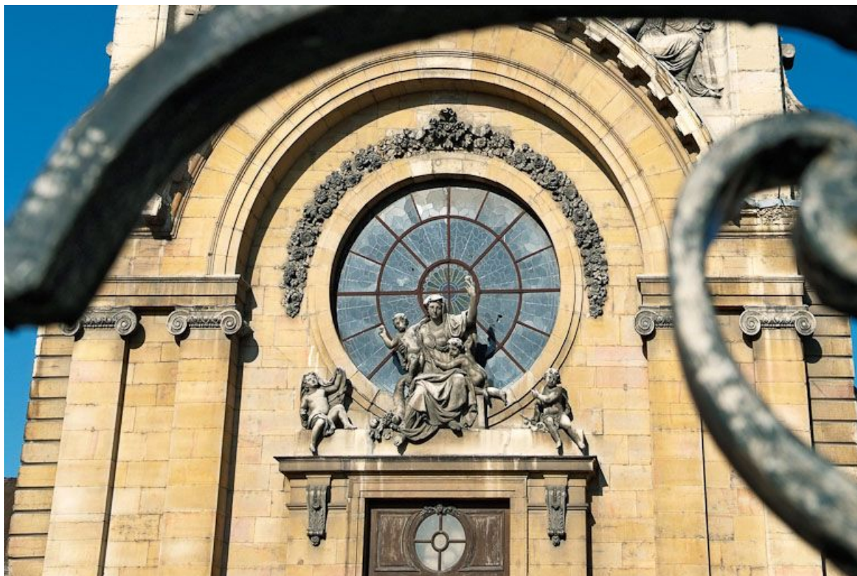
Façade de la chapelle, détail. 21, Dijon Hôpital
