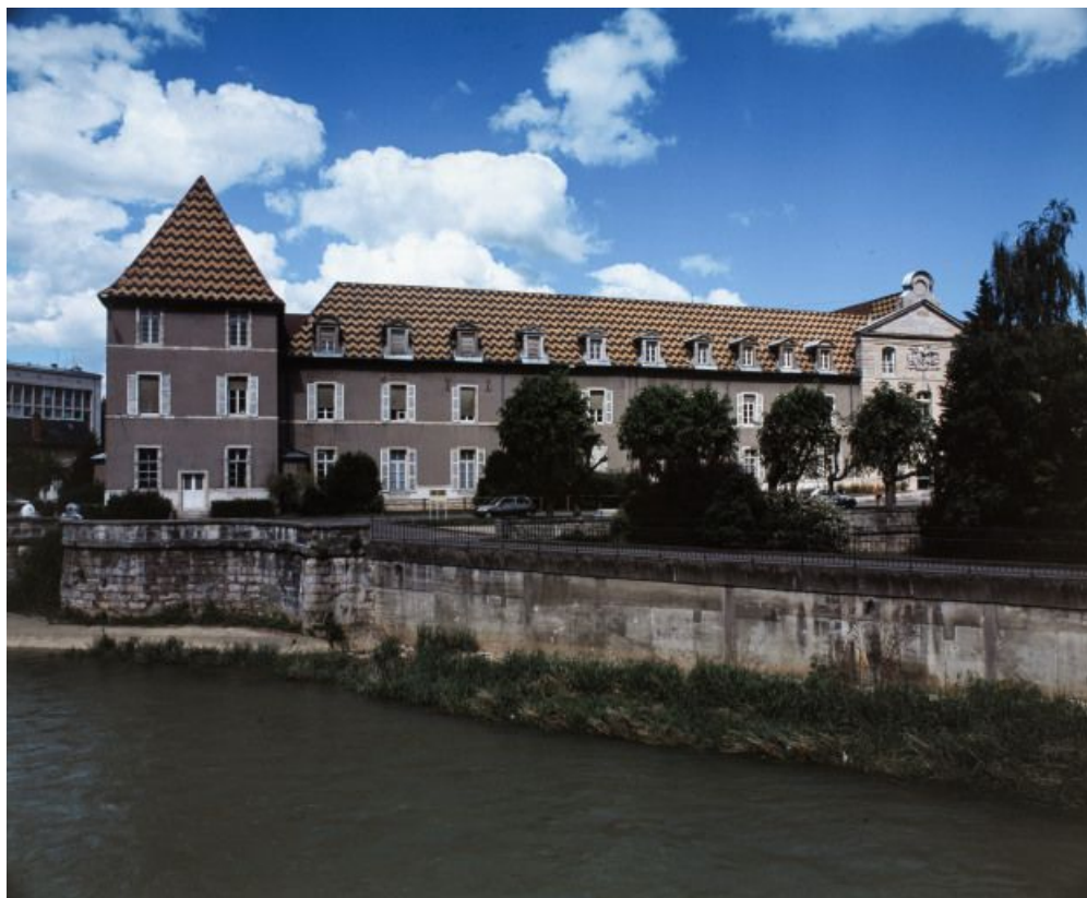
Façade postérieure (ouest) sur l'Ouche. 21, Dijon Hôpital
