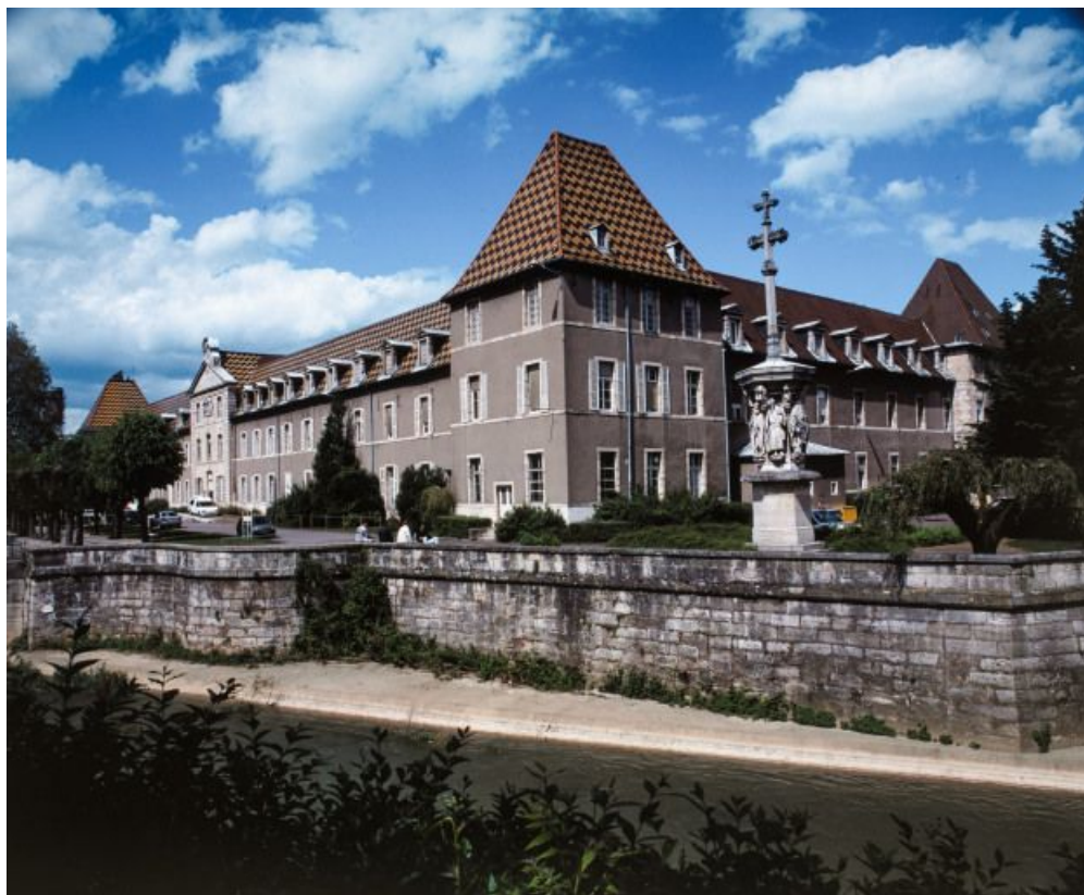
Façades postérieure (ouest) et latérale (sud). 21, Dijon Hôpital
