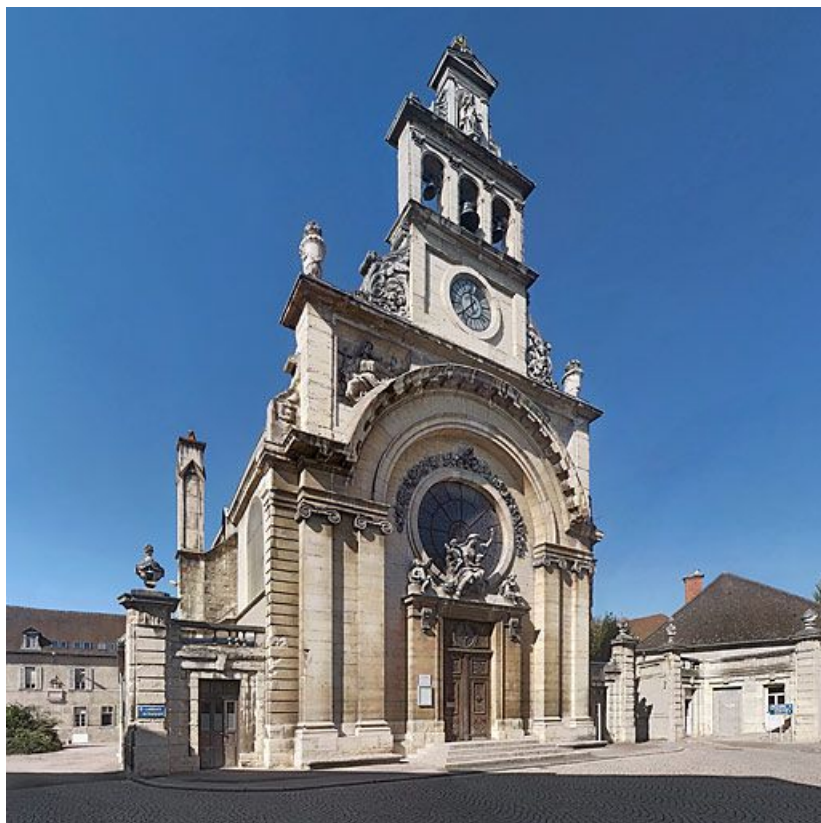
Façade de la chapelle. 21, Dijon Hôpital
