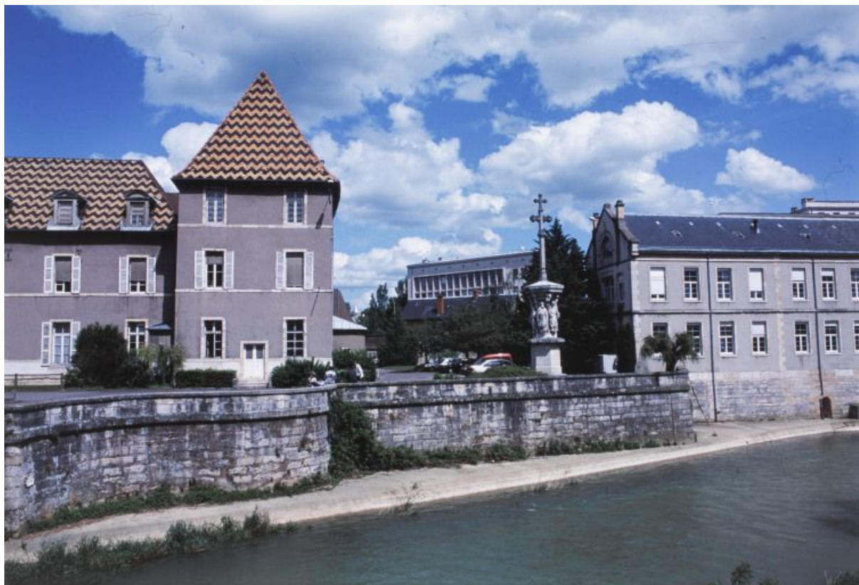
Façades postérieure (ouest) et latérale (sud). 21, Dijon Hôpital
