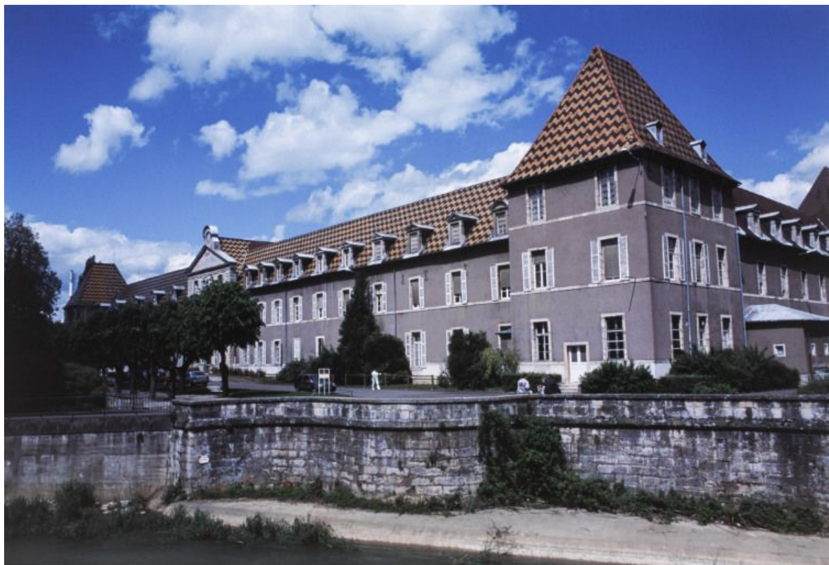
Façade postérieure (ouest) sur l'Ouche. 21, Dijon Hôpital
