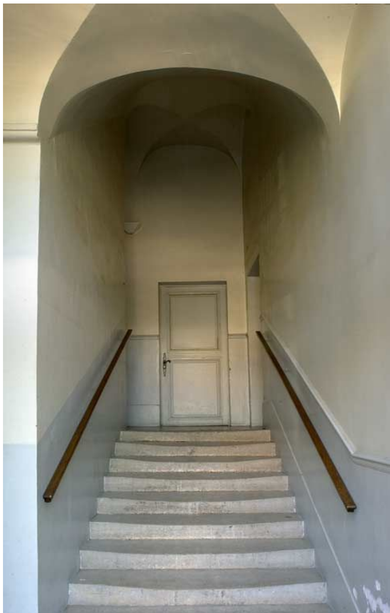
Ancien hôtel du gouverneur : escalier rampe sur rampe, 2e volée donnant accès au rez-de-chaussée surélevé. 21, Semur-en-Auxois, 7 rue de l' Hôpital
