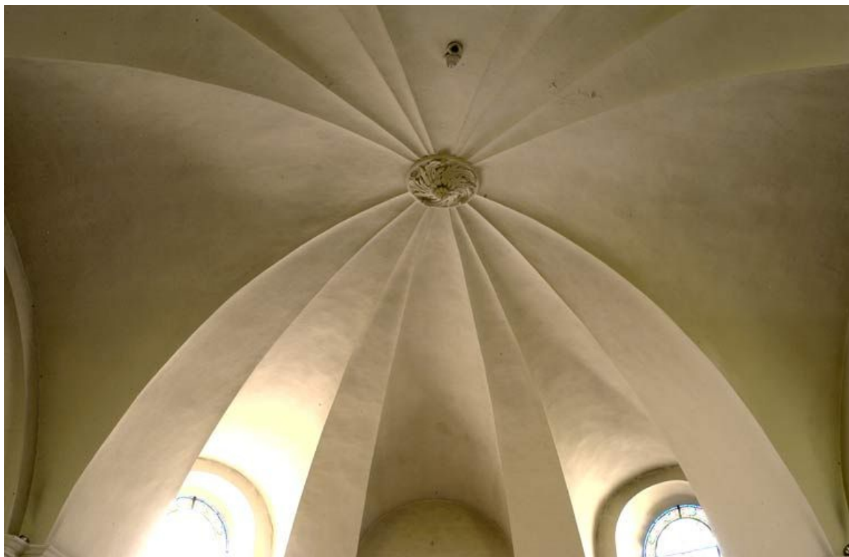
Aile droite : chapelle, voûtes d'arêtes à grands et petits quartiers alternés. 21, Semur-en-Auxois, 7 rue de l' Hôpital
