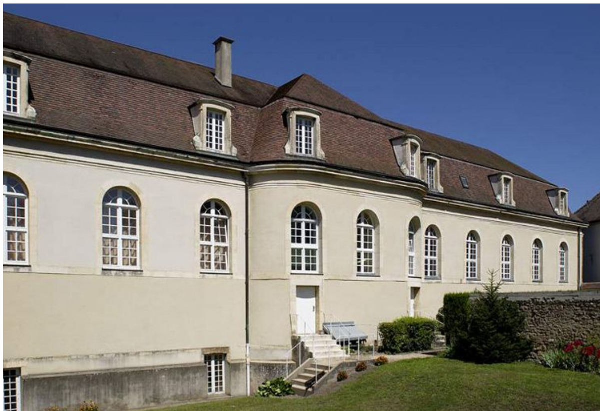
Aile gauche dite fondation Arnault : élévation postérieure.
