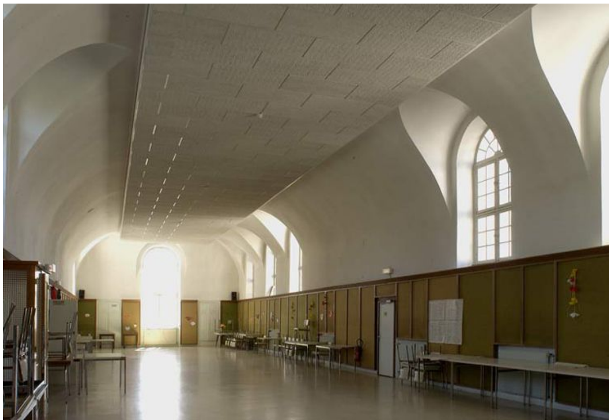
Aile droite : ancienne salle des femmes, salle Sainte-Marthe, vue d'ensemble depuis le mur droit. 21, Semur-en-Auxois, 7 rue de l' Hôpital
