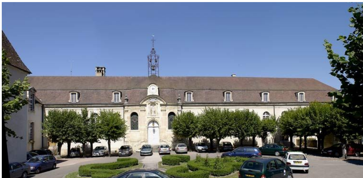
Aile droite : élévation sur la cour antérieure.
