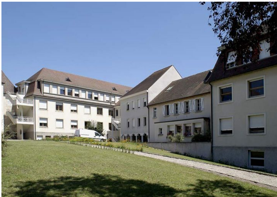
Bâtiments construits ou remaniés dans le 3e quart du 20e siècle par l'architecte R. M. Barade. 21, Semur-en-Auxois, 7 rue de l' Hôpital
