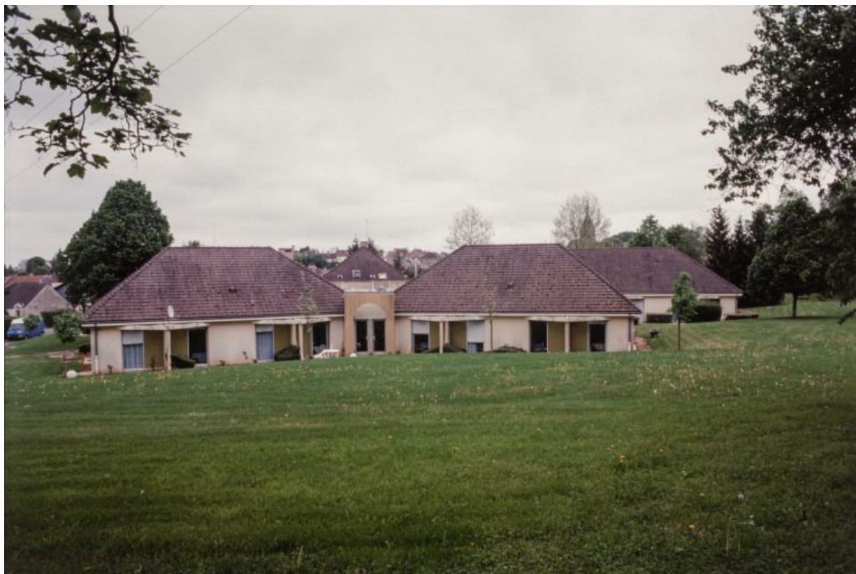
Vue d'ensemble des bâtiments.
