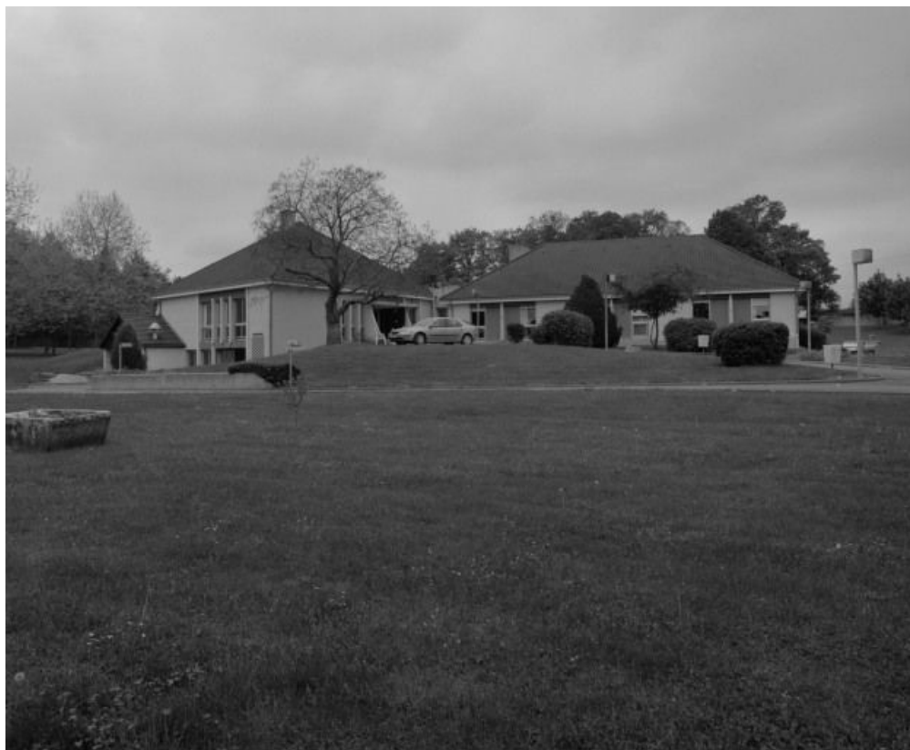
Vue d'ensemble des bâtiments.
