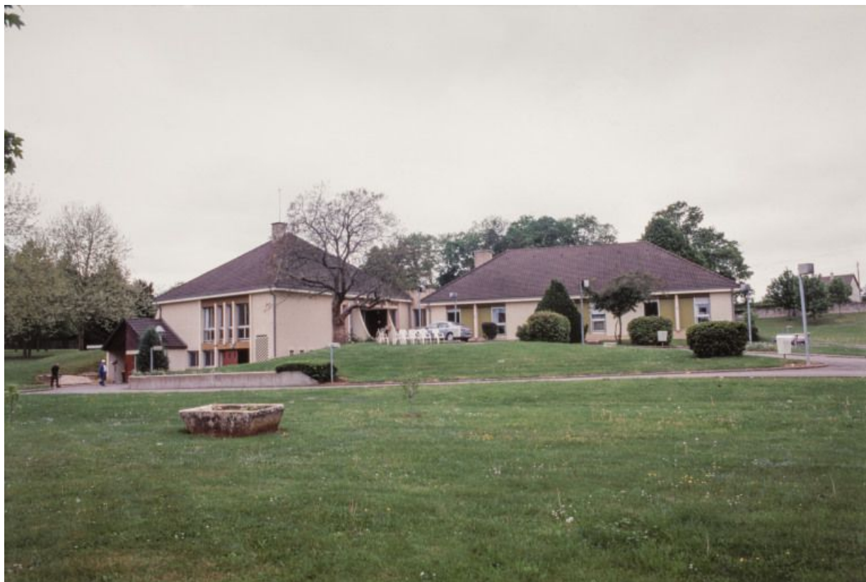
Vue d'ensemble des bâtiments.
