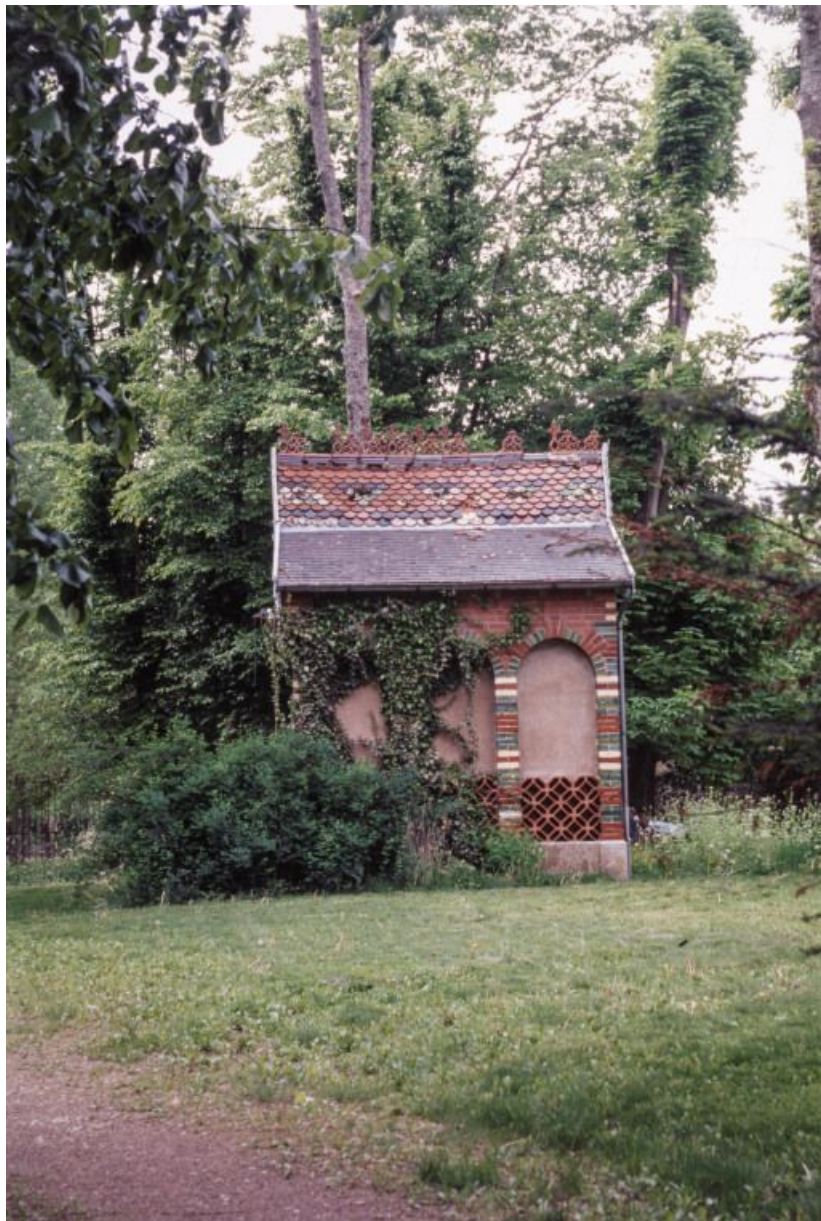
Chapelle du jardin : façade latérale. 21, Laignes Petite rue de la maison Dieu
