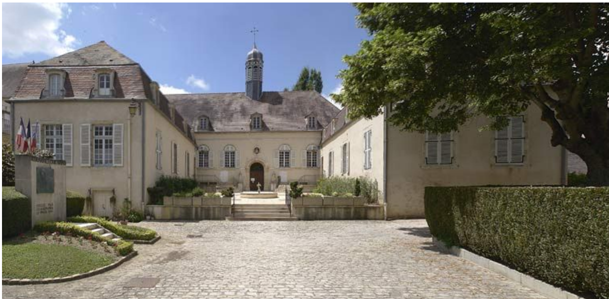
Façade sur cour principale.
