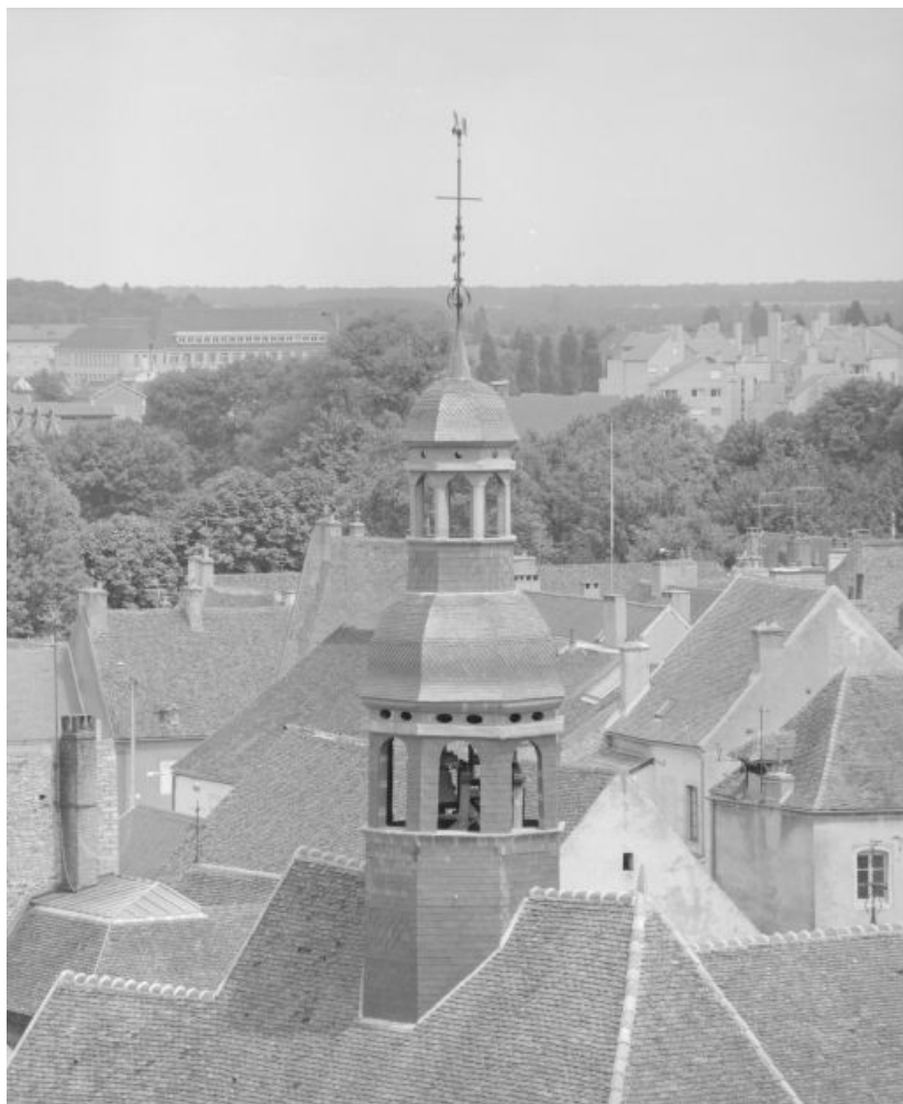
Vue du clocher depuis le beffroi.
