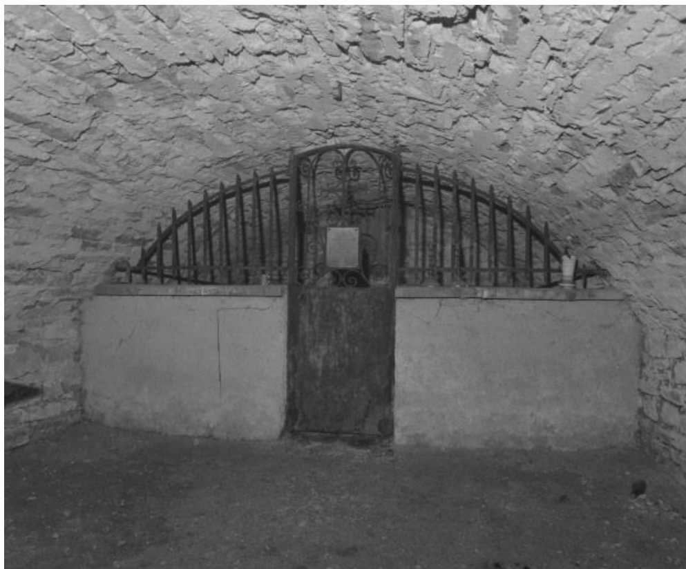
Caveau du collatéral gauche, vue prise de l'est ; partie où reposent les 12 premières soeurs de l'hôpital, décédées de 1715 à 1783. 21, Beaune Lorraine
