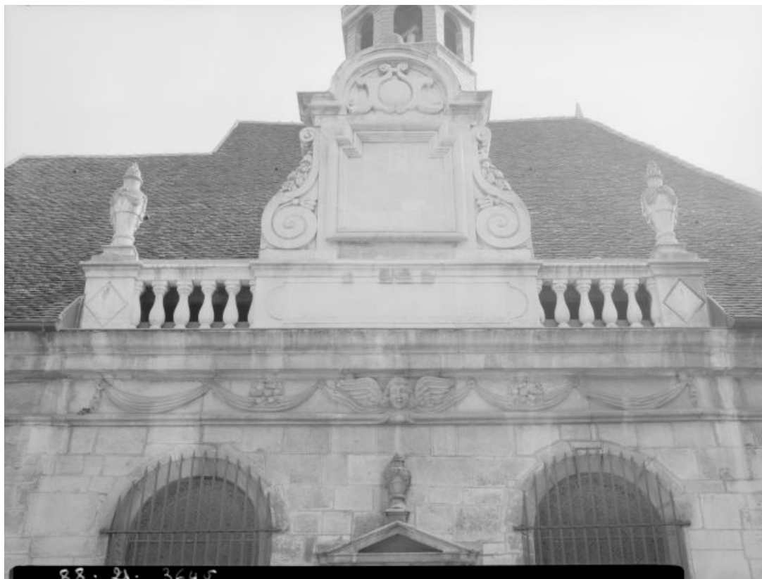
Détail du couronnement de la façade.
