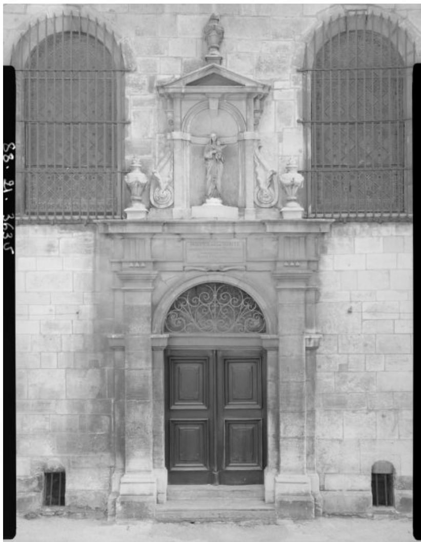
Détail de la façade.
