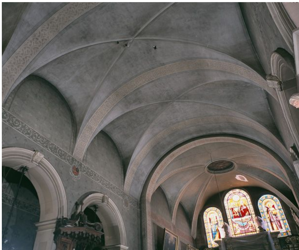
Voûtes du vaisseau central de la nef et du chœur.
