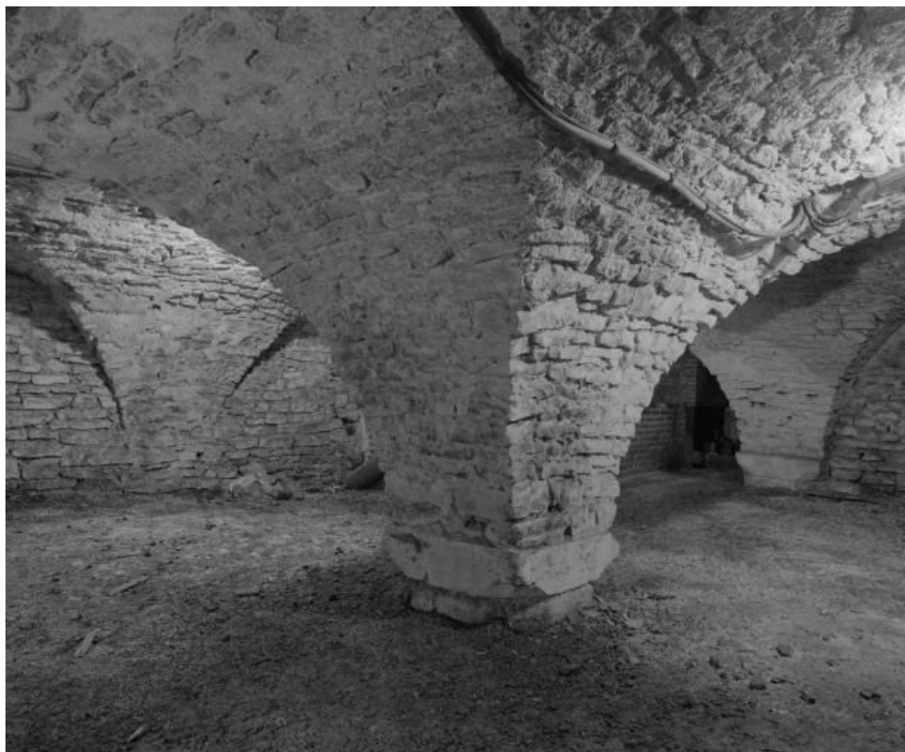
Partie de la crypte se prolongeant sous la sacristie.
