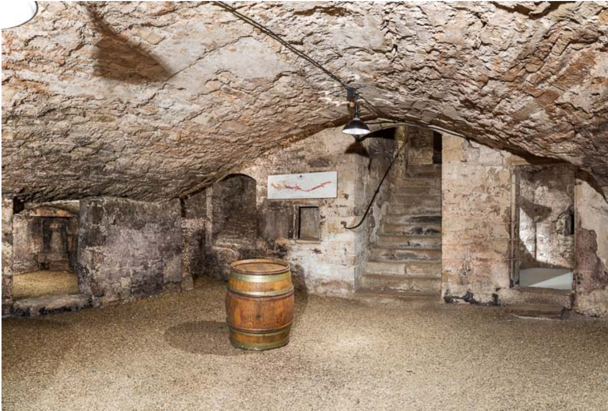
Casemate inférieure de la tour sud-ouest.
