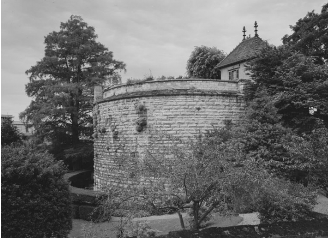
Tour sud-est depuis la rue du Château (1988).
