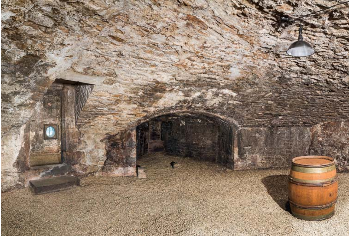
Casemate inférieure de la tour sud-ouest.
