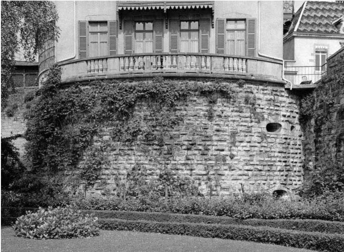
Tour sud-ouest depuis le fossé.
