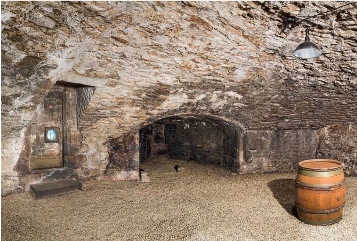
Casemate inférieure de la tour sud-ouest.
