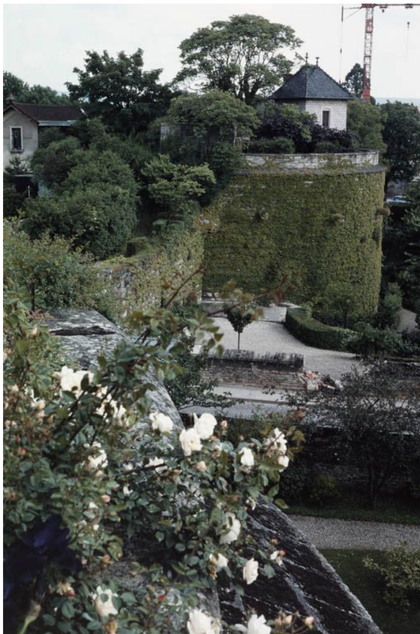
Tour nord-est et courtine est : vue d'ensemble prise depuis la plateforme de la tour sud-est. 21, Beaune rue du Château
