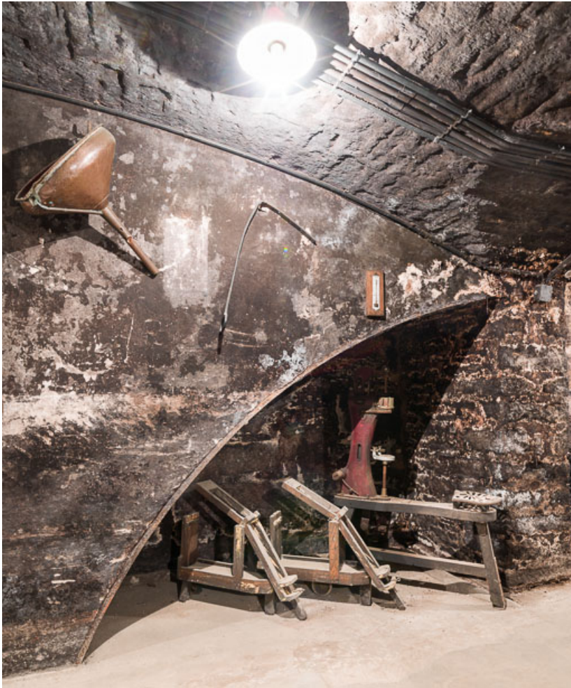
Couloir de circulation le long de l'ancien rempart (1er sous-sol) : anciens outils. 21, Beaune rue du Château
