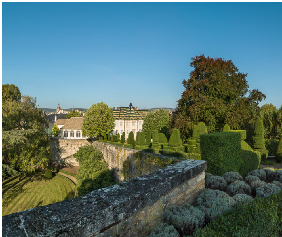
La rampe depuis le belvédère.
