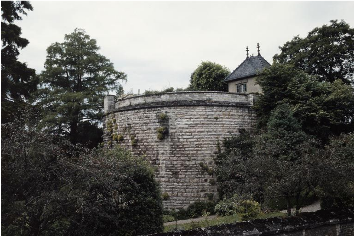
Tour sud-est depuis la rue du château.
