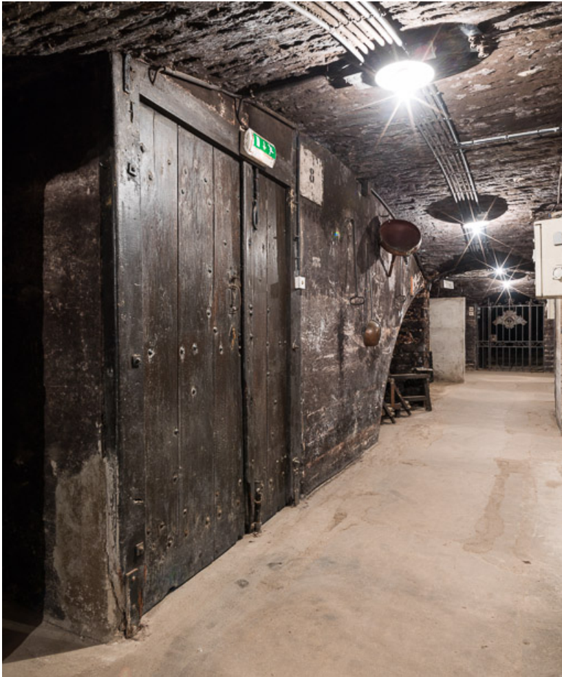
Porte d'accès vers les anciens chais.
