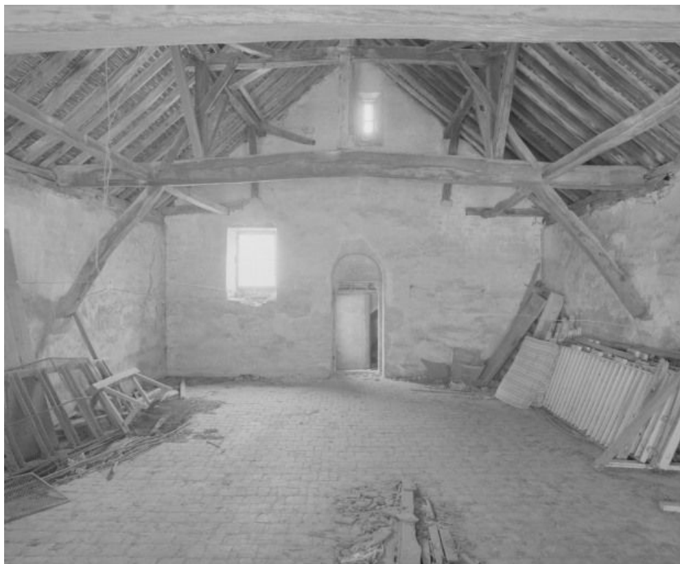
Niveau supérieur : vue d'ensemble prise depuis le pignon sur rue.
